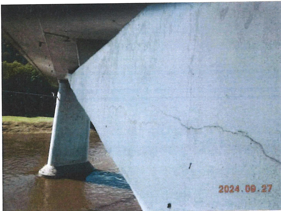
24S1-018_ZU_SCHADEN-148_FELD2-7_STIRNSEITE_LINKS
