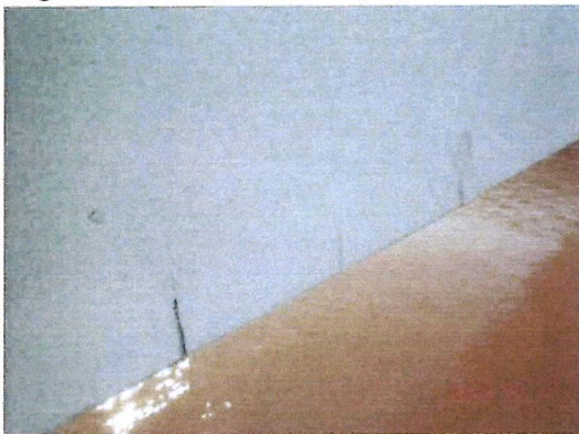
2024S1_150_Q-RISSE_ZUGBANDSTIRNSEITE_RECHTS
