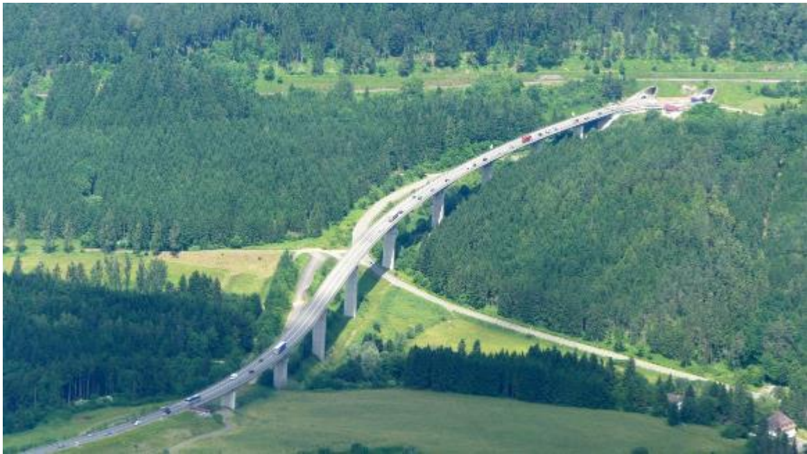
Abbildung 2: Gauchachtalbrücke und Tunnel Döggingen
