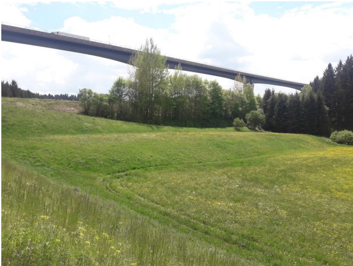
Abbildung 8: Gauchachtalbrücke und Damm von Nordwesten her
