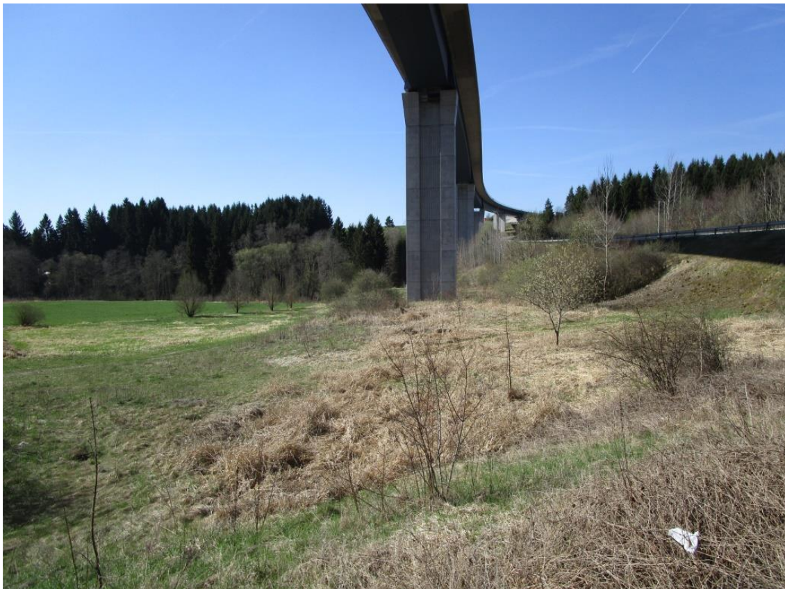
Abbildung 7: Blickrichtung von Standort mittig unter der Brücke Richtung westliches Widerlager
