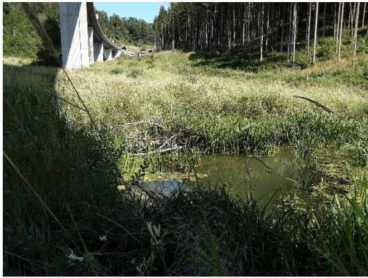
Foto: Blick auf den Tümpel unter der bestehenden Brücke
