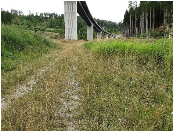
Foto: Überwachsener Weg, rechtsseitig Rohrglanzgras-Röhricht
