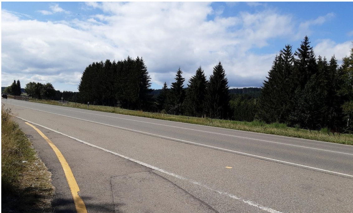
Abbildung 10: Blick von der Behelfsabfahrt über die B 31 in Richtung Nordwesten
