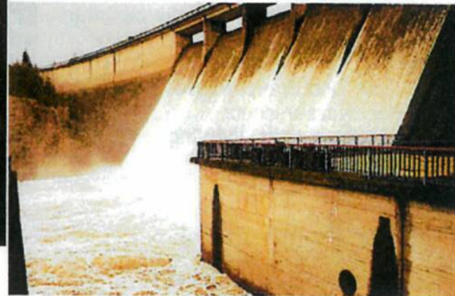
TS Wendefurth HW-Überlauf mit ca. 87,0 \text{ m}^3/\text{s} am 13.4.1994 (aus Berichte des LAU 1995, Heft 15)
