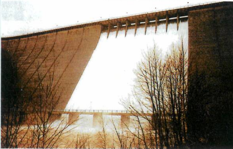
Rappbodetalsperre HW-Überlauf mit ca. 20,0 \text{ m}^3/\text{s} am 13.4.1994 (aus Berichte des LAU 1995, Heft 15)
