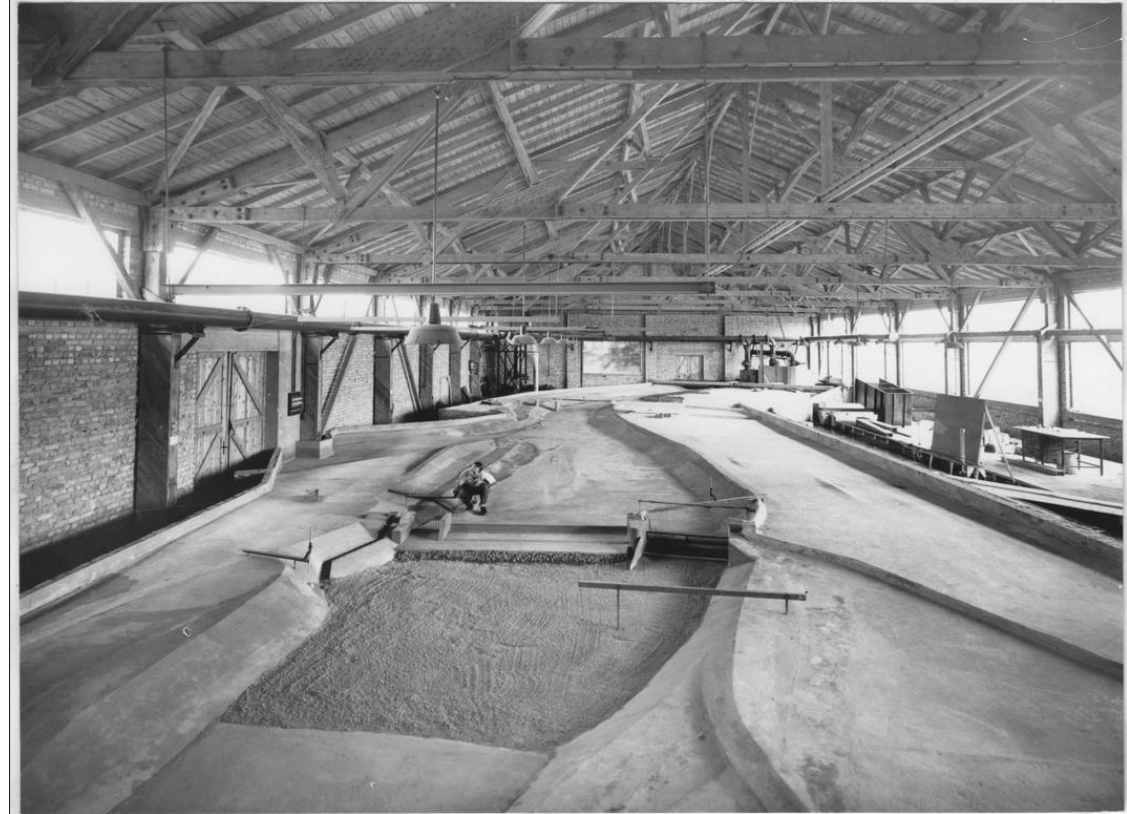
Hydraulisches Modell der alten Schleusenanlage Hanekenfähr in der BAW, Karlsruhe, 1953
