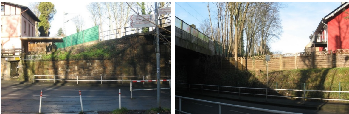
Abbildung 5 Unterführung Comesstraße/Rheinstraße in Brühl (Bild links: Westseite, Bild rechts: Ostseite)
