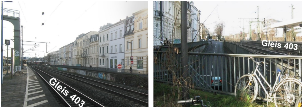
Abbildung 14 Platzverhältnisse am Bahnhof Bonn Hauptbahnhof
