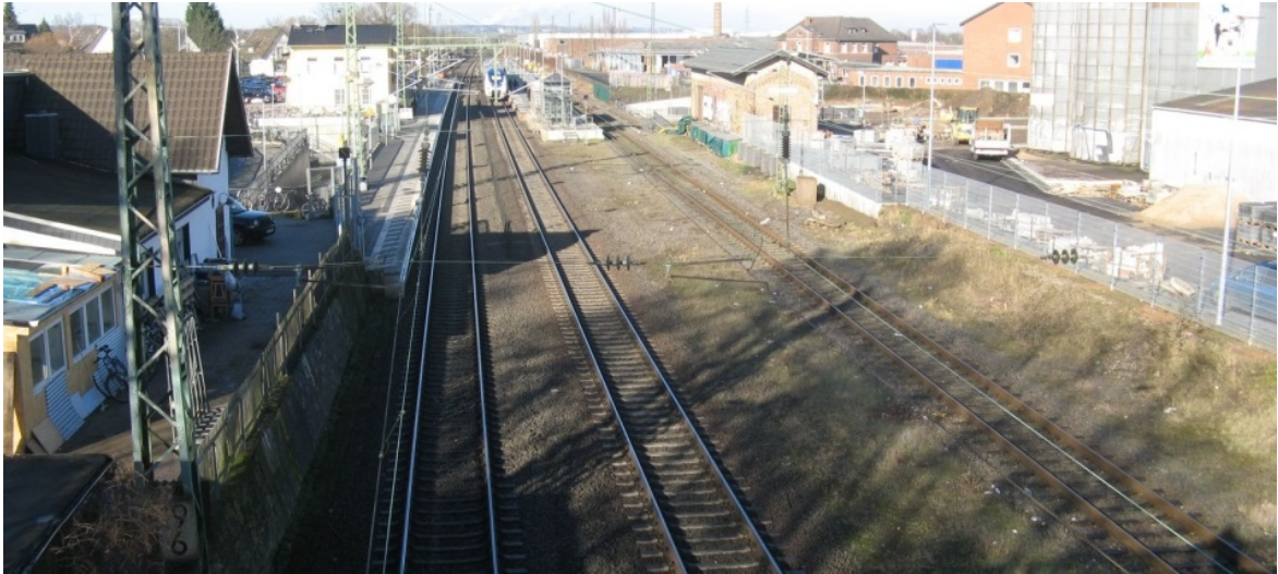
Abbildung 7 Bahnhof Sechtem mit Blick in Richtung Hürth-Kalscheuren (Richtung Nordwest)
