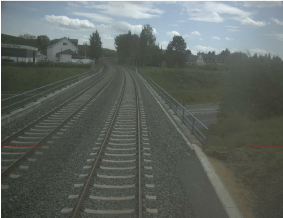
Abbildung 44: Eisenbahnüberführung B56 Euskirchener Straße
