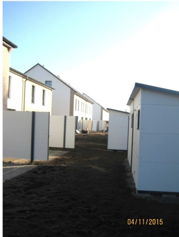
Abb.8: Einbau Oberboden – Gebäude A und B
