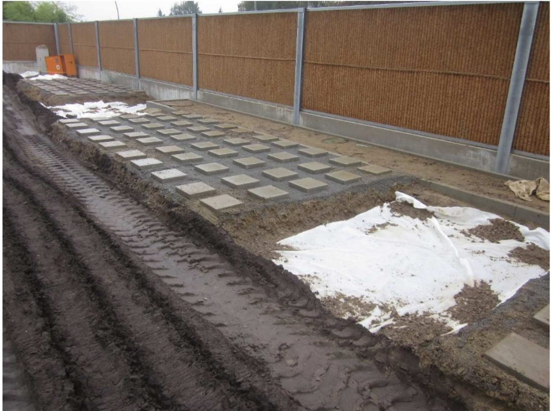
Abb.2: Einbau Vlies und Oberboden – Gebäude D – Blick S
