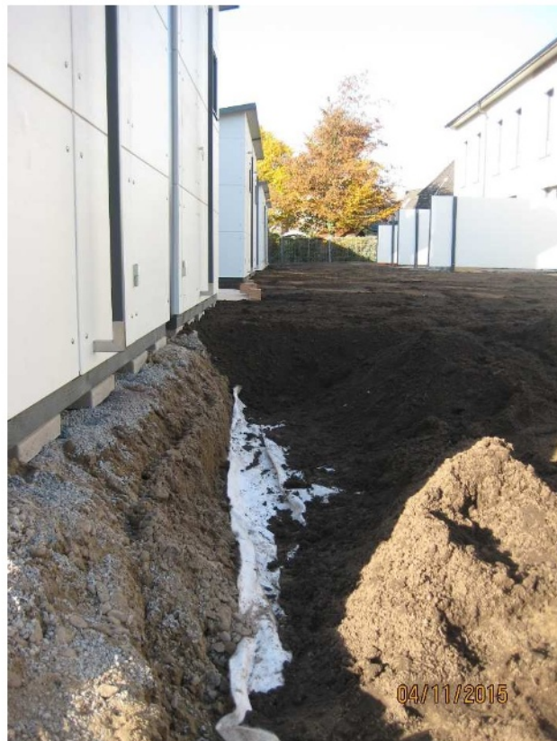
Abb.7: Einbau Vlies und Oberboden – Gebäude E
