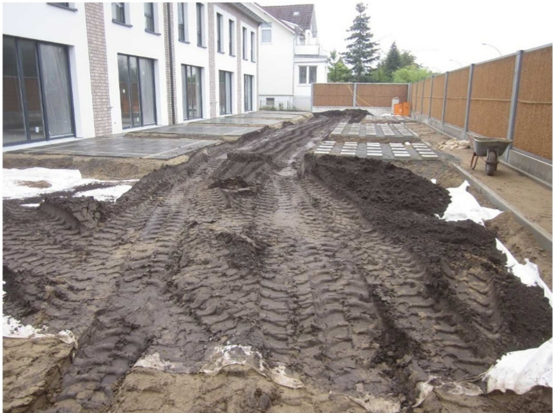
Abb.1: Einbau Vlies und Oberboden – Gebäude D – Blick SE
