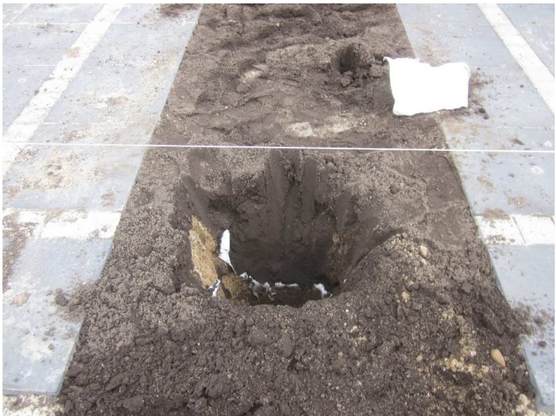
Abb.9: Einbau Vlies und Oberboden – Gebäude A
