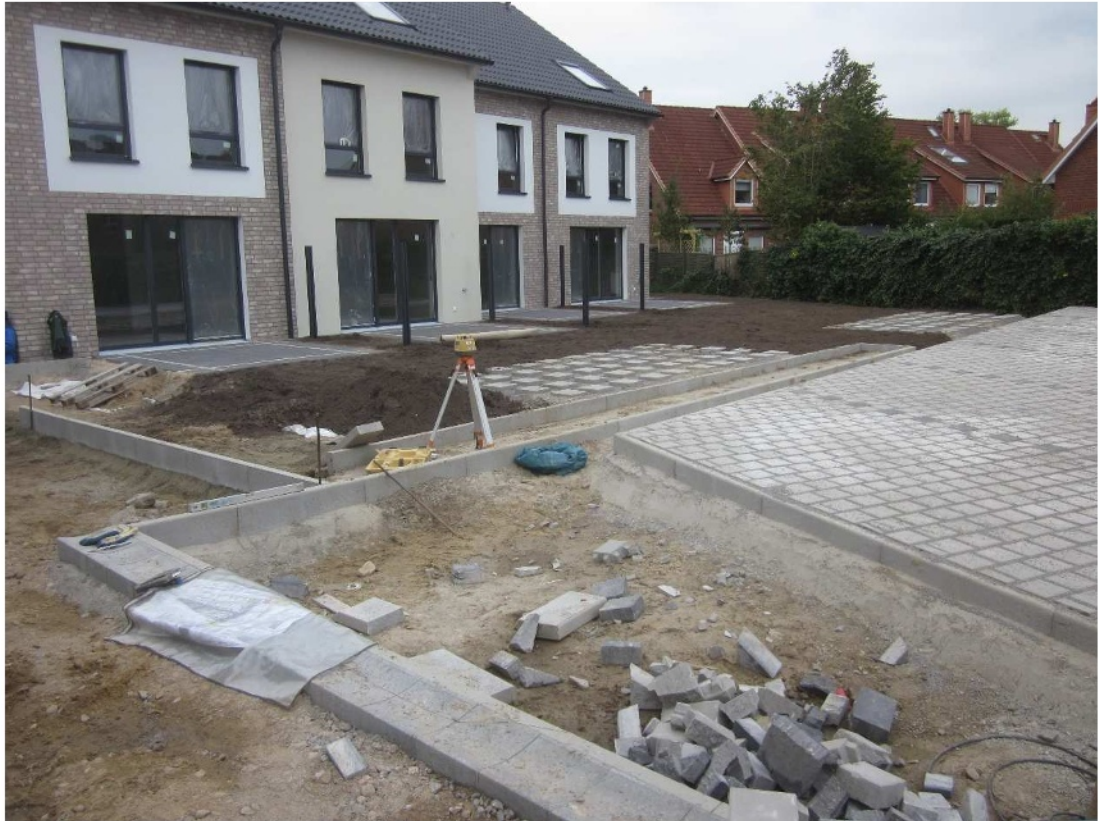
Abb.4: Einbau Oberboden Gebäude F
