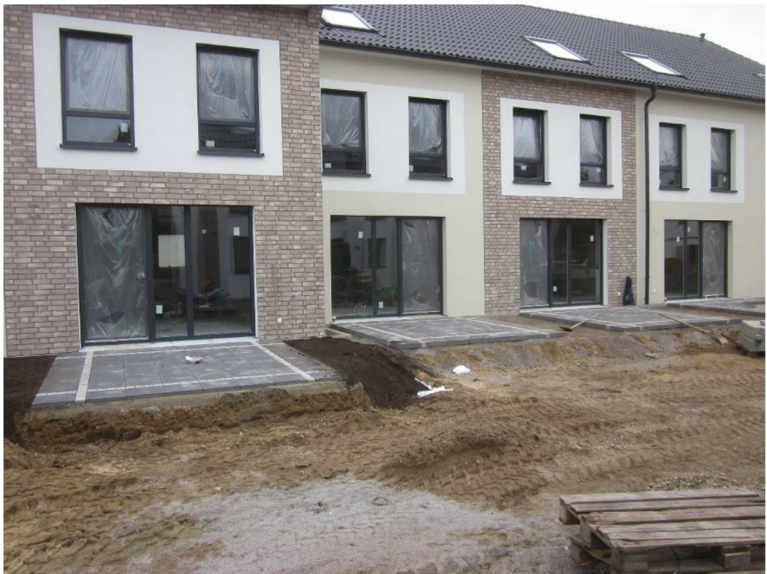
Abb.5: Einbau Vlies und Oberboden – Gebäude E
