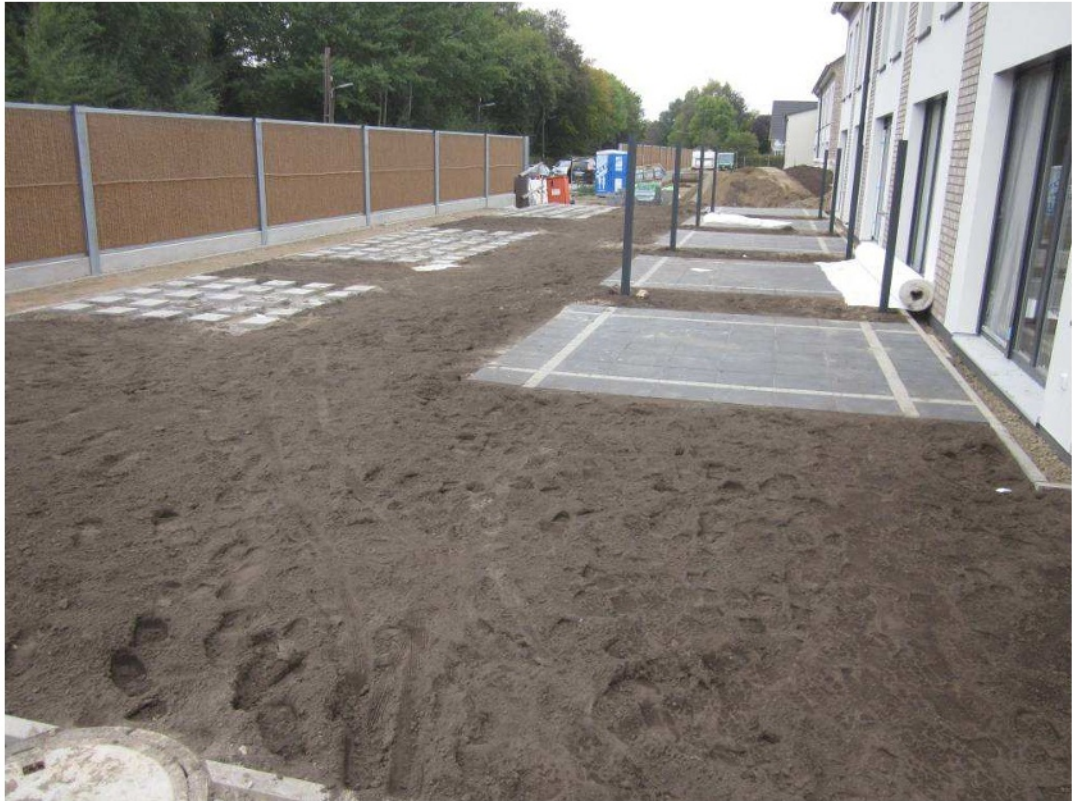
Abb.6: Einbau Vlies und Oberboden – Gebäude D und C
