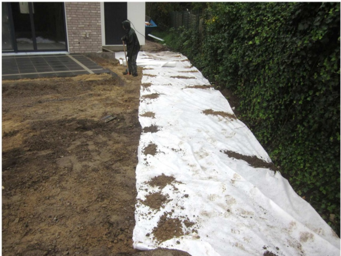
Abb.3: Einbau Vlies – Gebäude F – Blick Ga40
