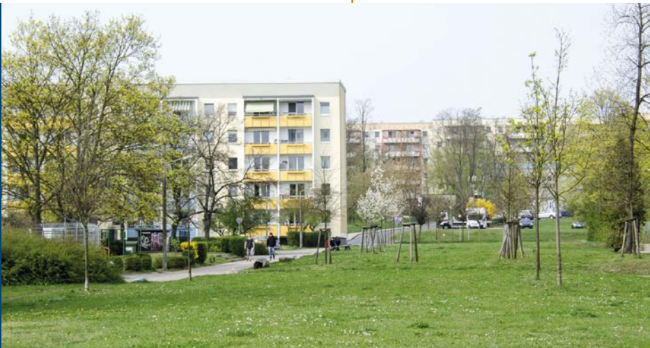
Sanierter Plattenbau, Stadtteil Süd in Frankfurt
