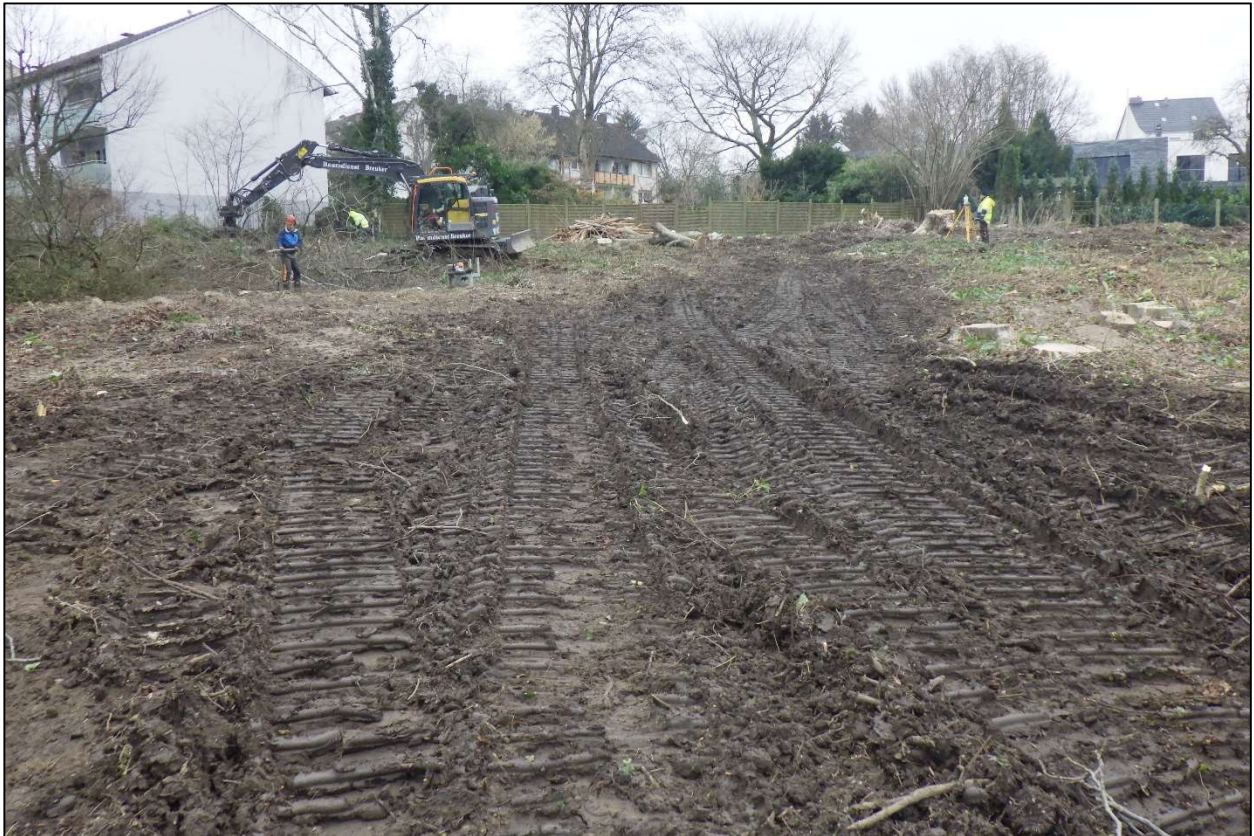
Abb. 1: finale Fällarbeiten im westlichen Baufeld; durch häufige Überfahrten zur Sammelstelle der gefällten Gehölze können bei den aktuellen Bodenfeuchten Bodenschadverdichtungen auftreten, dem ist durch das Auslegen von im Baufeld vorhandenen Stahlplatten zu begegnen.
