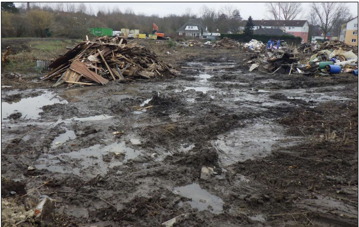
Abb. 2: Pfützenbildung im zentralen Teil des westlichen Baufelds.
