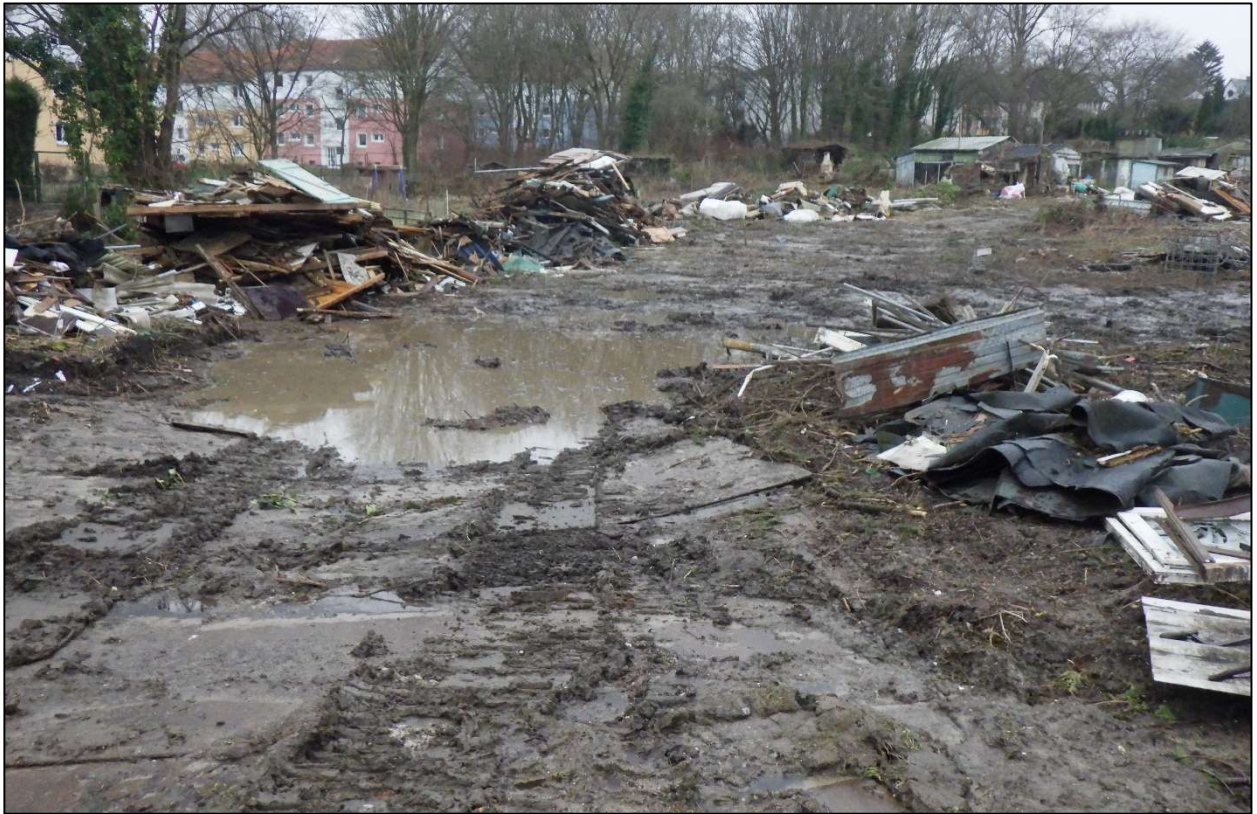
Abb. 1: Pfützenbildung in Senkenbereichen des westlichen Baufeldes. Das Material der abgerissenen Hütten ist bereits rechts und links des zukünftigen Straßenverlaufs aufgemietet und wartet auf Abtransport.
