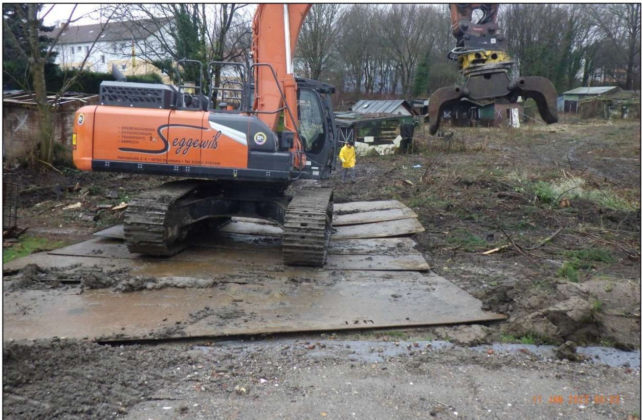
Abb. 1: Befahrung der unbefestigten Substrate nur nach Auslegen von mobilen Baustraßenelementen
