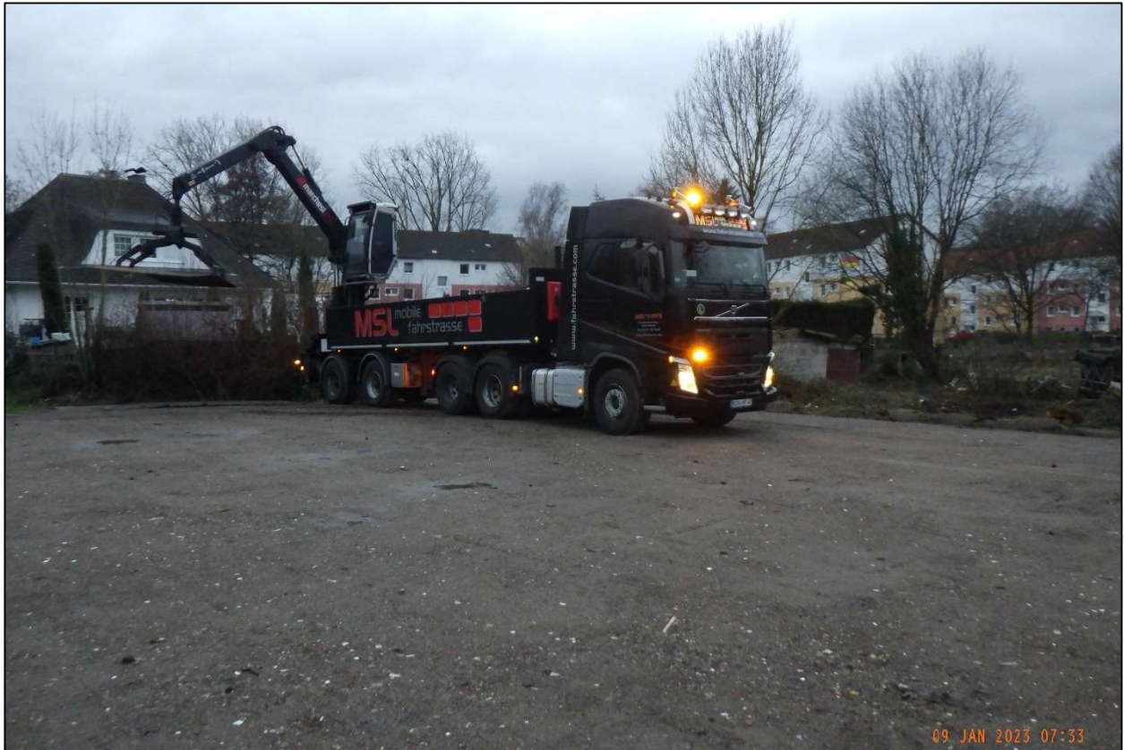
Abb. 1: Abladen der mobilen Baustraßenelemente
