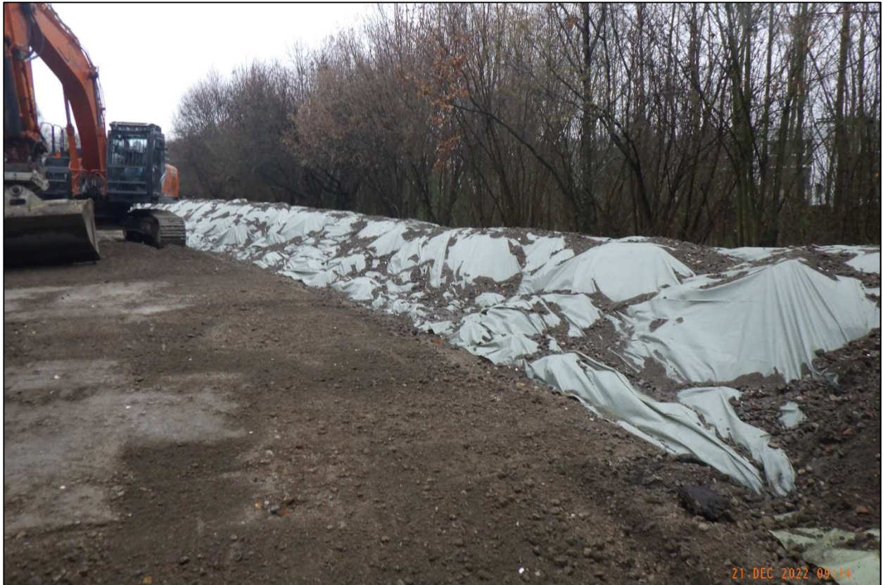
Abb. 1: Finale Arbeiten an der aus RCL-Material hergestellten Baustelleneinfahrt; Die Miete wurde aufgrund der potenziellen Gefahr von Schadstoffauswaschungen mit Folie abgedeckt.
