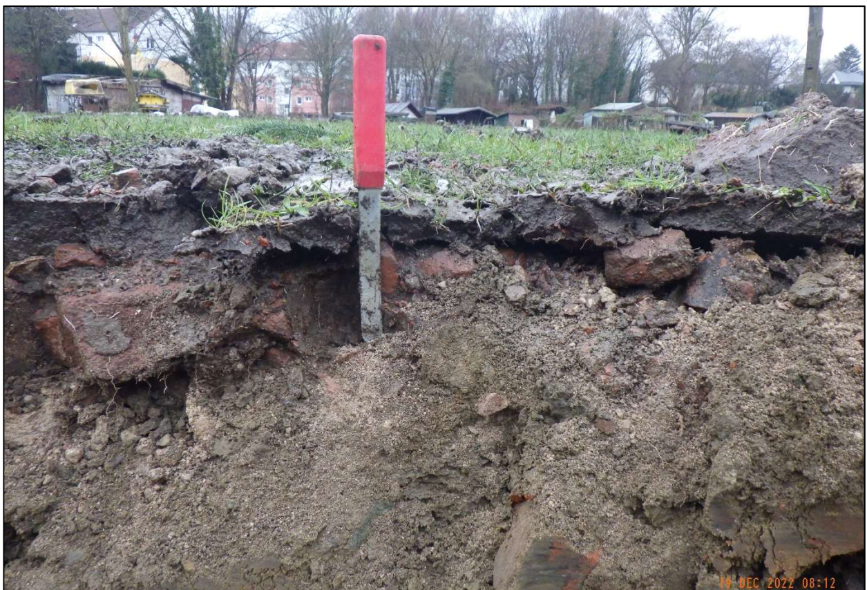
Abb. 4: Oberbodenhorizont über Altablagerung, Blickrichtung W
