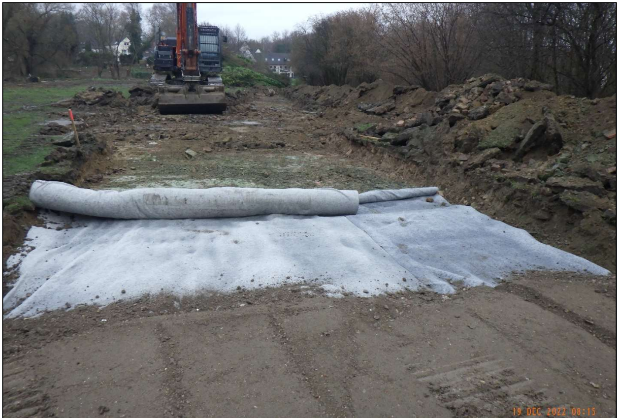
Abb. 1: Anlage der Baustraße auf überlappenden Vliesbahnen im Einfahrtbereich Pferdewiese
