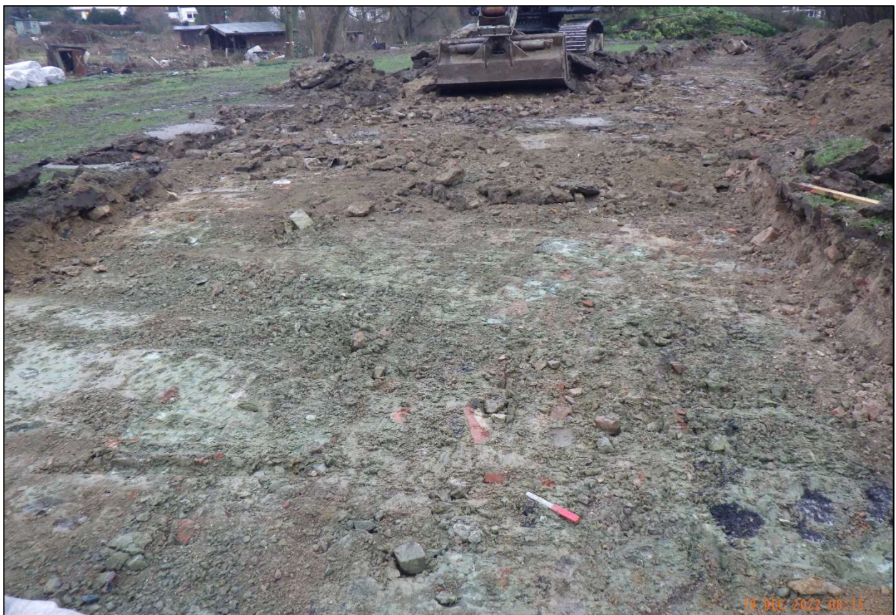
Abb. 6: Freigelegte Altablagerung
