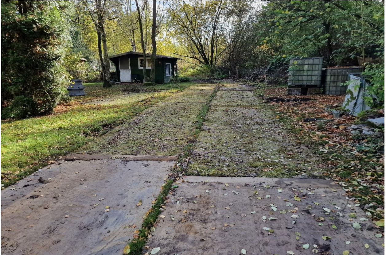
Abb. 7: Rückbau der Stahlplatten
