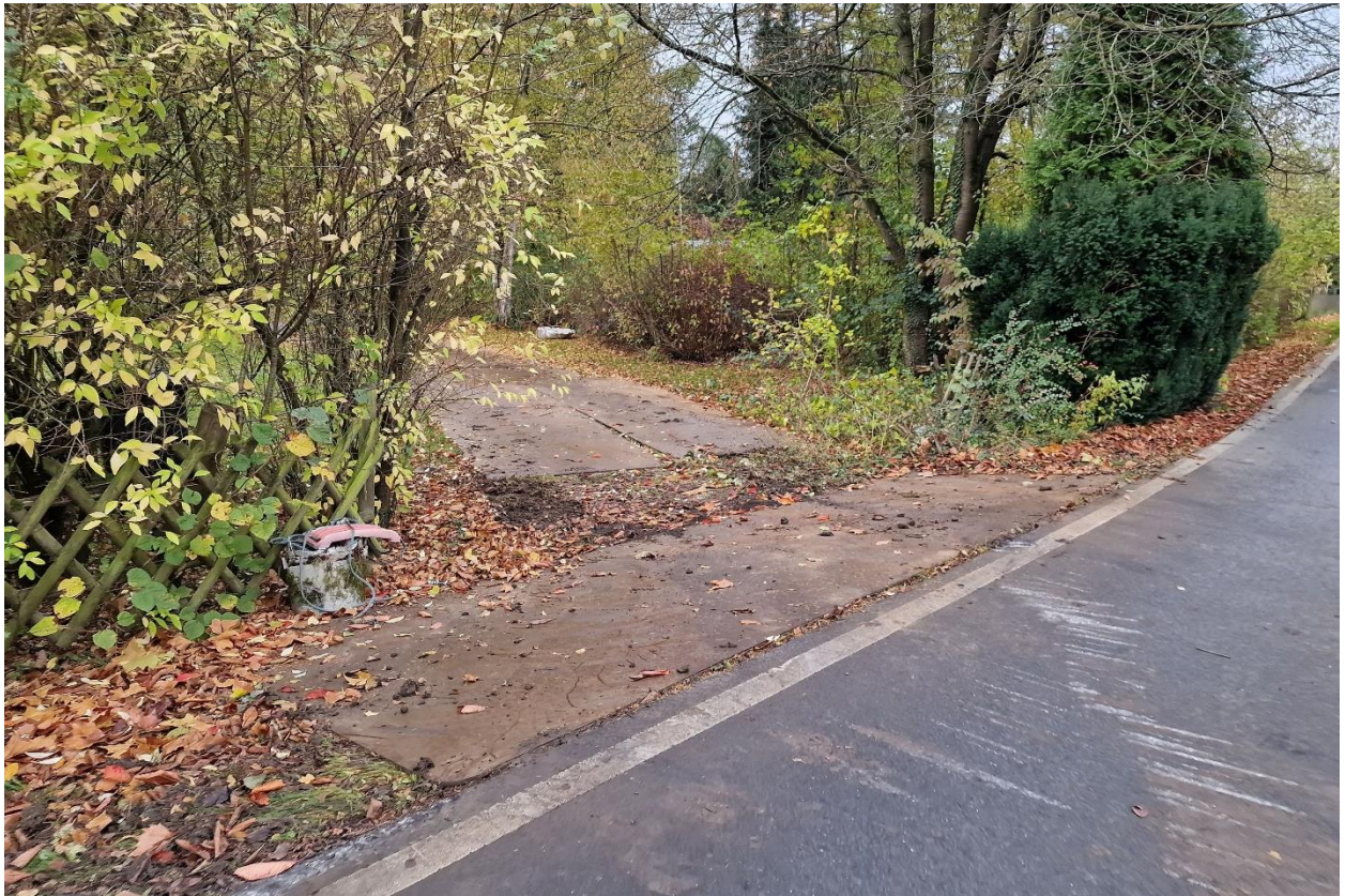
Abb. 1: Einfahrtsbereich an der Grotenbachstr.
