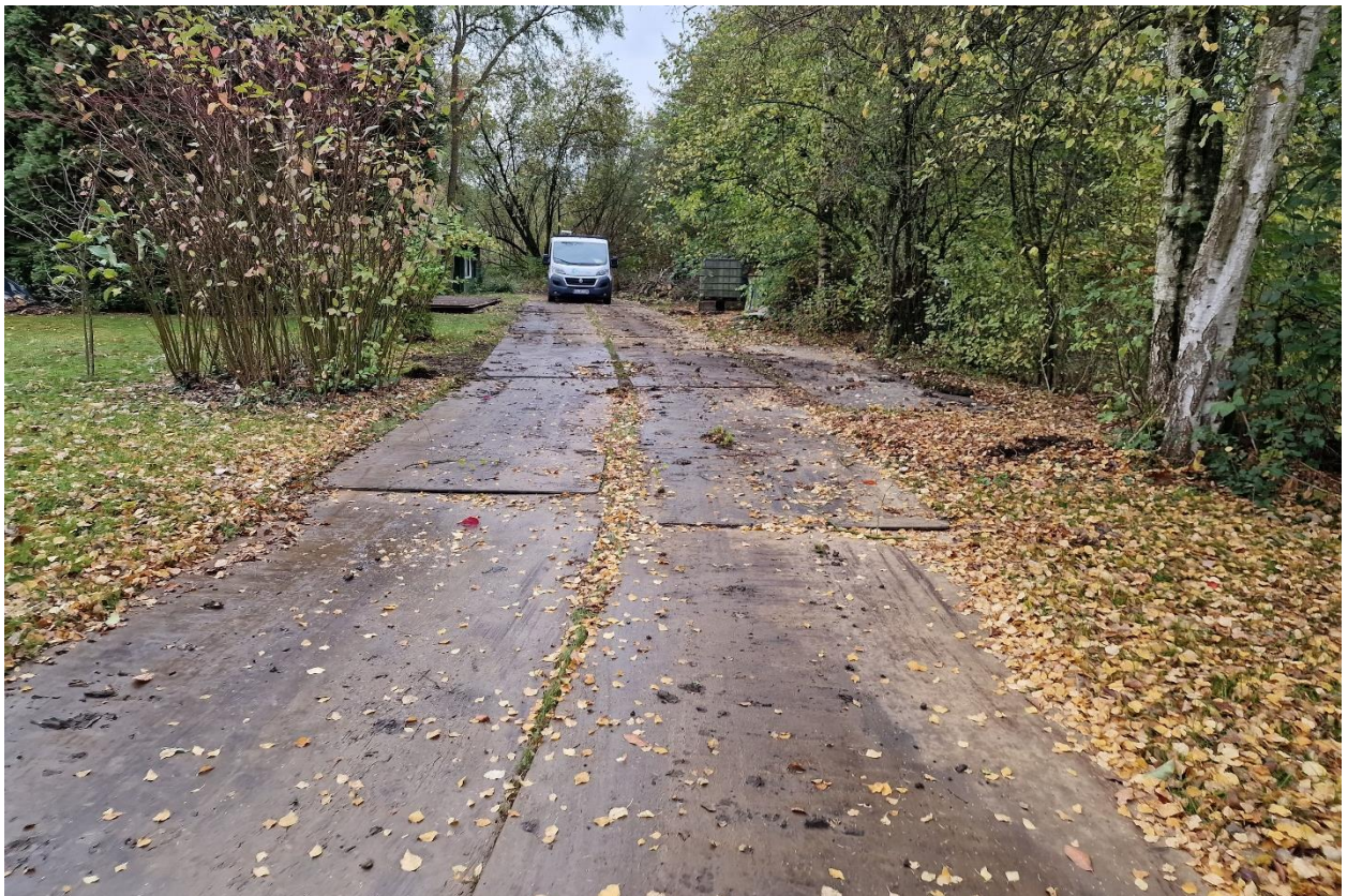
Abb. 2: mit Stahlplatten befestigter Zufahrtsbereich
