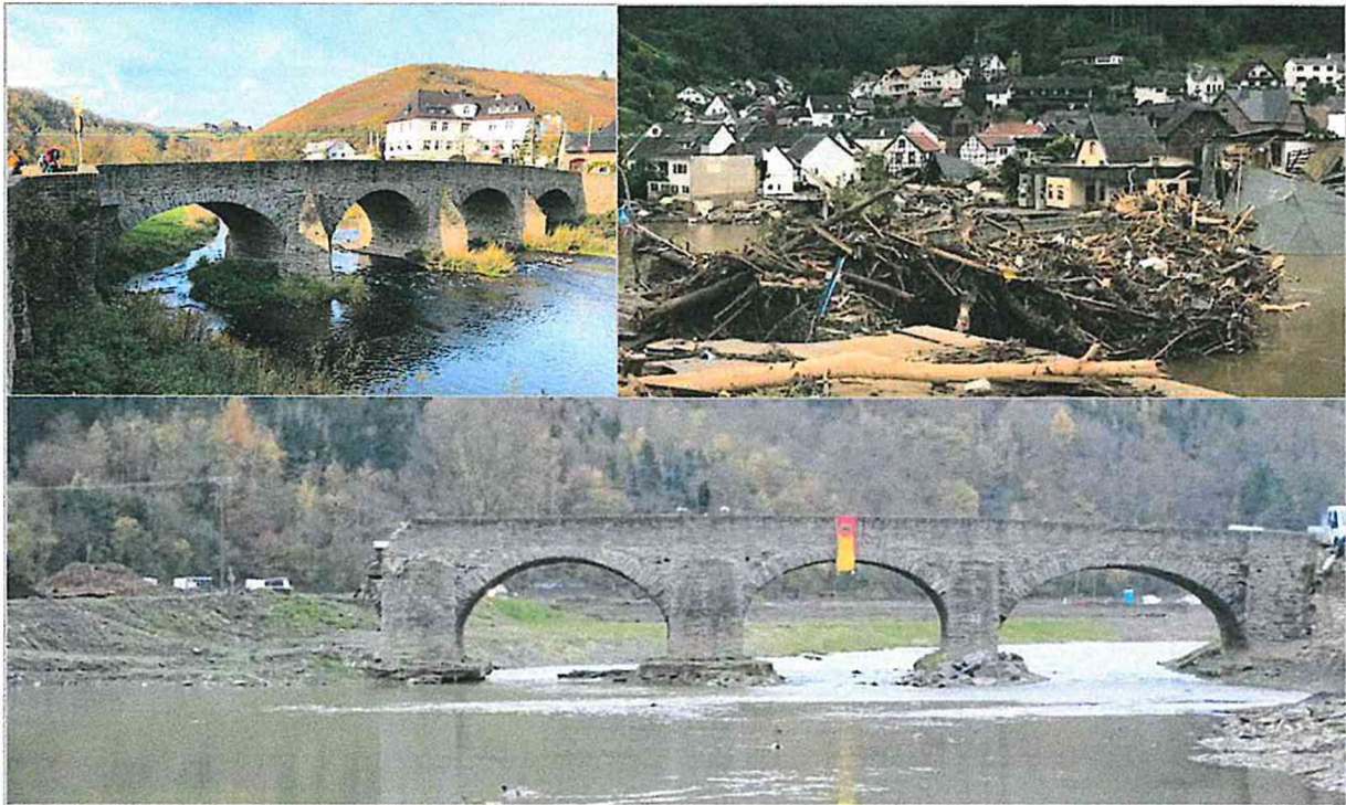
Abb. 1-2: Die Nepomukbrücke vor (oben links; Foto privat) während und nach dem Ereignis (oben rechts und unten; Leonardt, Andrá und Partner)
