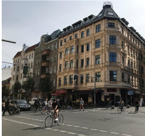
Schlesische Straße / Falckensteinstraße: Unzureichender Ausbau des Knotenpunkts und Signalisierung
