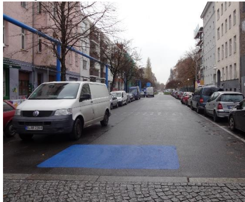
Mangelhafte Sichtbarkeit des Verkehrsberuhigten Bereichs, z. B. in der Cuvrystraße
