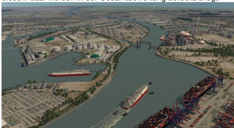
Abbildung 4 : Anlaufen Moorburg Stealth-View
