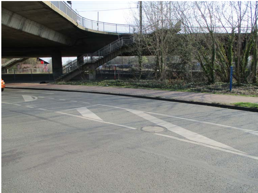
01. Ansicht Kleinrammbohrung BS 01/18
