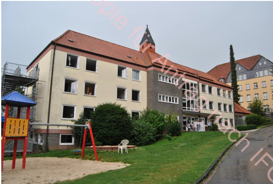
Schwesternwohnheim mit Küche von Nordwesten, 2020 (LWL-DLBW/Stegmann)
