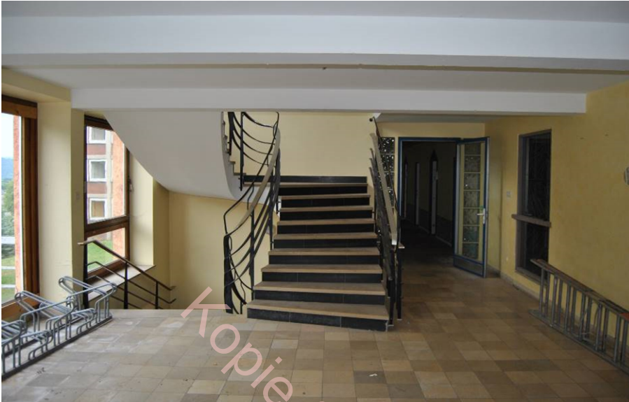
Eingangshalle, Blick nach Süden mit Haupttreppe, 2020 (LWL-DLBW/Stegmann)
