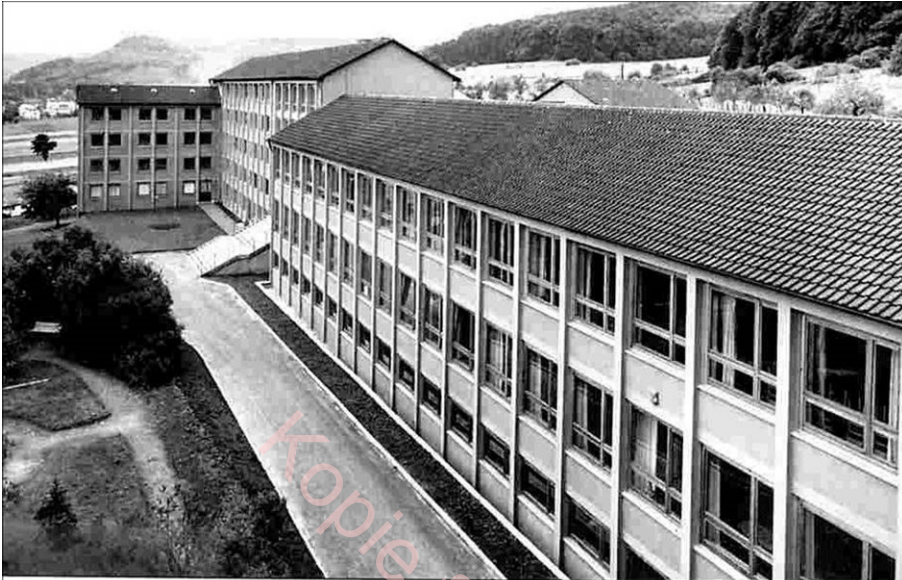
Schul- und Internatstrakt von Norden, 1957 (Hohmann/Schulz 2012, S. 377)
