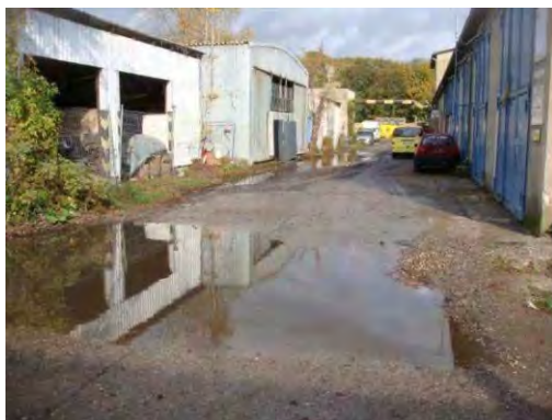
Schadstelle, bei Regen
