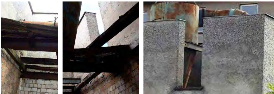
Stahlträger und Dachkonstruktion
