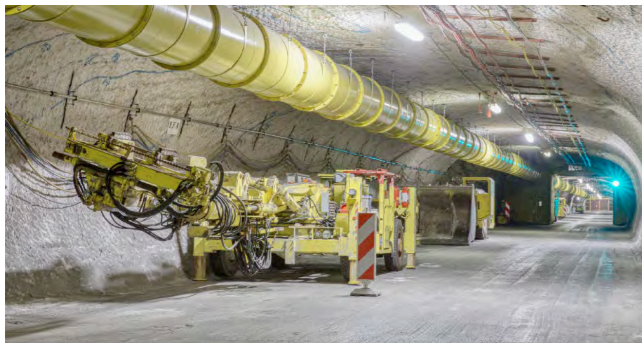
Bergwerk Gorleben: Hauptförderstrecke, 840-m-Sohle
