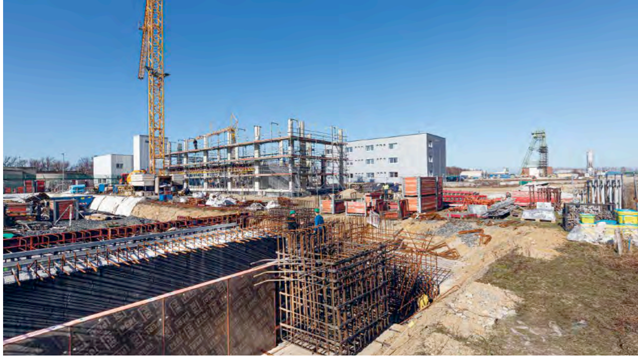
Schachtanlage Konrad: Am Schacht Konrad 2
