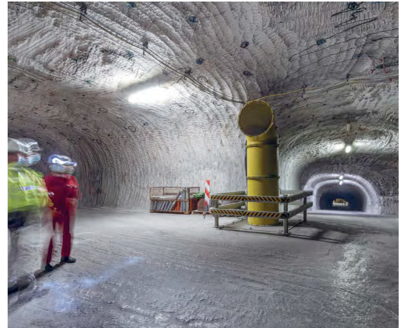
Bergwerk Gorleben: Abwetterlutte, 820-m-Sohle
