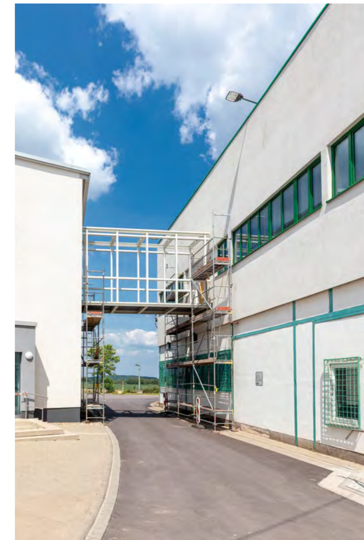
Endlager Morsleben, Tragkonstruktion für neue Seilfahrtsbrücke
