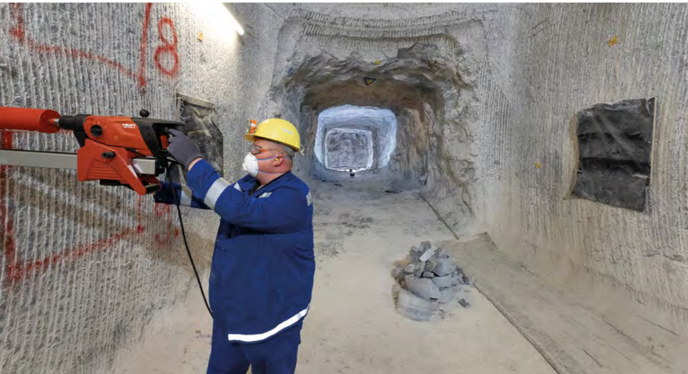
Philipp Wilke bei der Erstellung von Kernbohrungen
