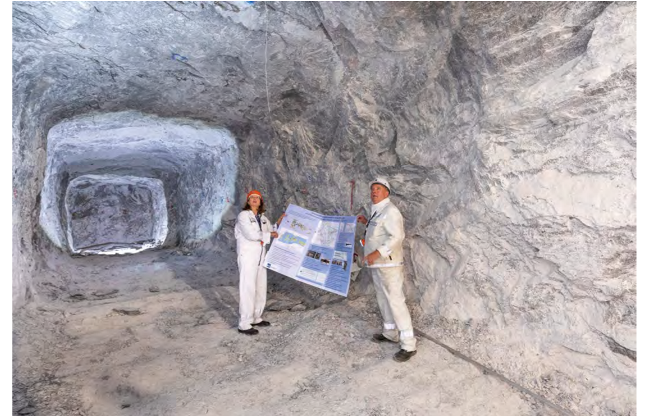
Endlager Morsleben: Demonstrationsbauwerk für den dauerhaften Verschluss von Strecken
