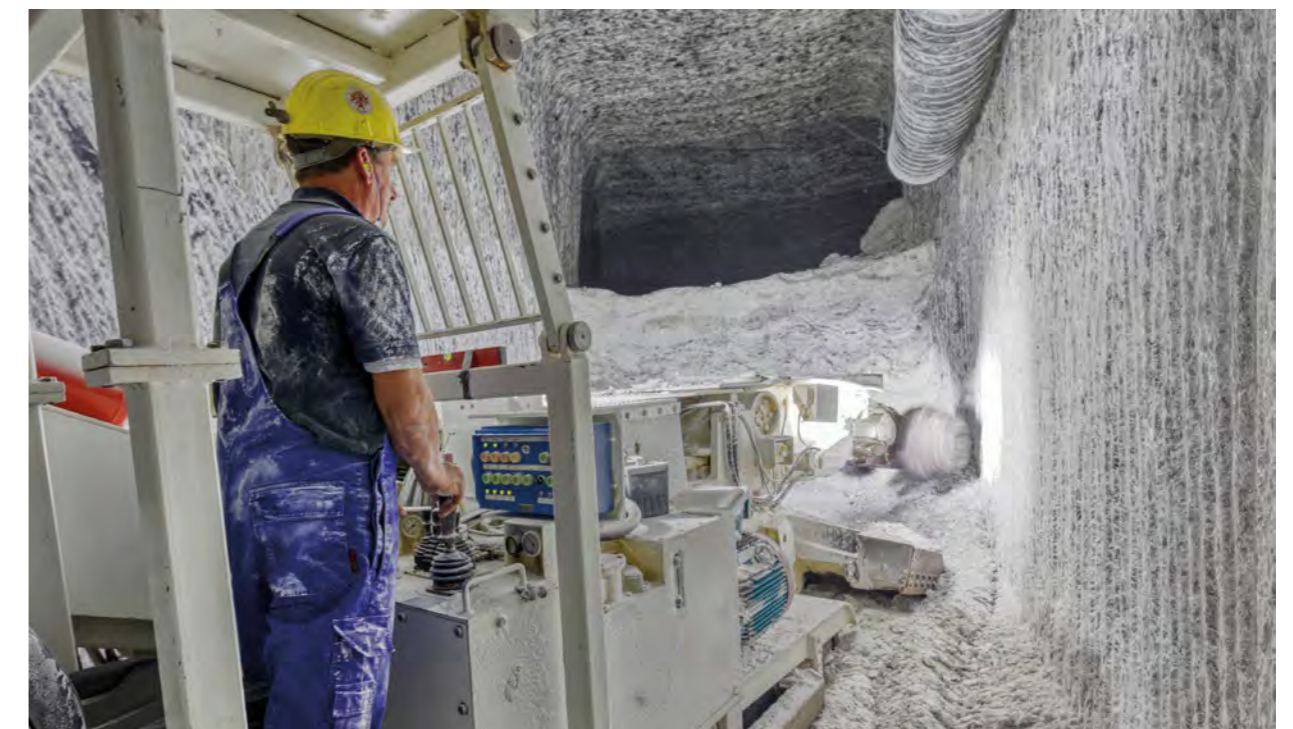
Matthias Bösche bei der Erstellung des Versatzortes für den Test der Mischanlage
