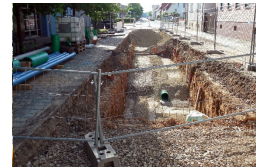
Straßenbau/Leitungsverlegung (Symbolbild Pixabay, 2021 abgerufen)
