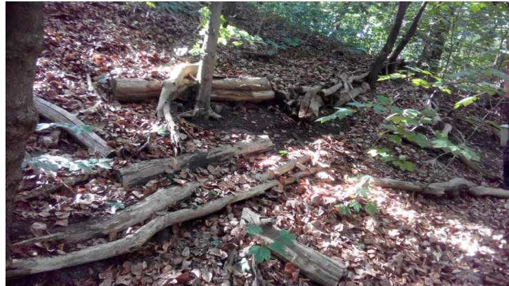
Abb. 52: Totholzbarrieren und Benjeshecken als Erosionsschutz und Besucherlenkung am Entenpfuhl
