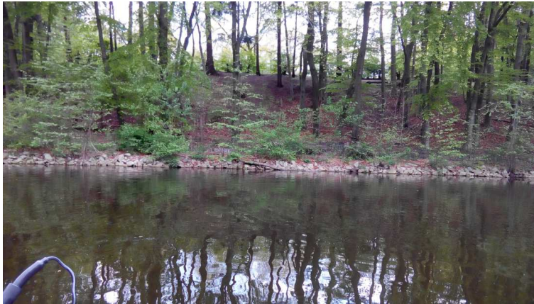
Möwensee, Abschnitt 2: Uferbefestigung durch Steinschüttung
