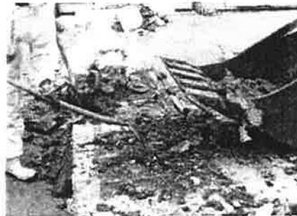
4) Reinigen der Wetter - und Tragschale mit 3/4 Zoll Wasserschlauch
