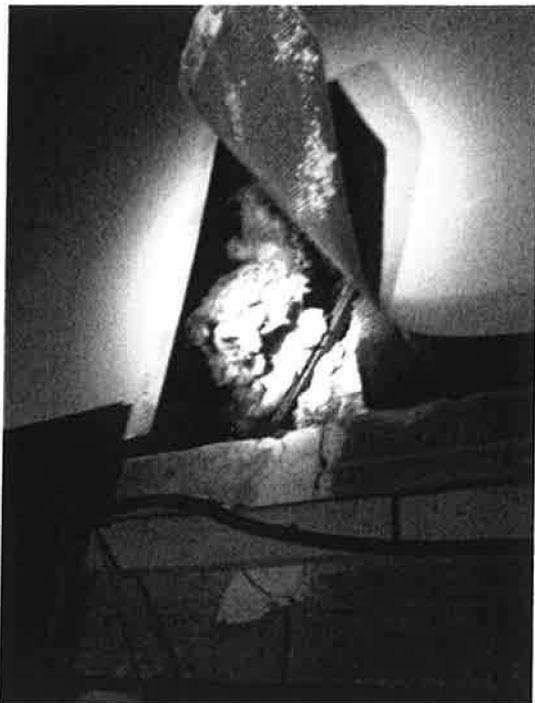
Foto-Nr. 07 – Ansicht Kuppelisolierung unter Lochblech Planetarium / EG, links
