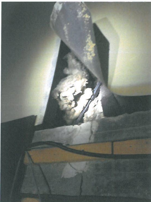
Foto-Nr. 04 – Ansicht Kuppelisolierung unter Lochblech Planetarium im Erdgeschoss (06108 Halle, Peißnitzinsel 4a, ehem. „Raumflugplanetarium“)
