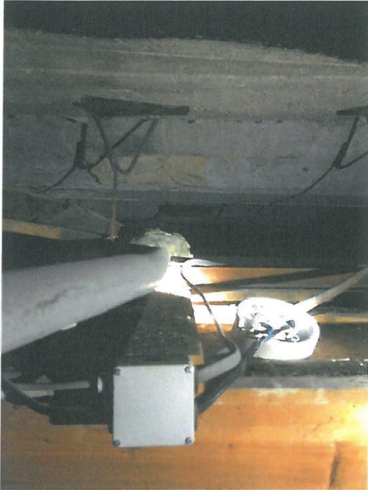
Foto-Nr. 03 – Ansicht Rohrisolierung Planetarium im Erdgeschoss, Anbau rechts (06108 Halle, Peißnitzinsel 4a, ehem. „Raumflugplanetarium“)
