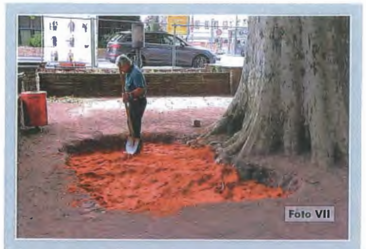
Die Sondiergräben um den Stammfuß bleiben nach oben offen (kein Abschluss mit wassergebundener Decke).
