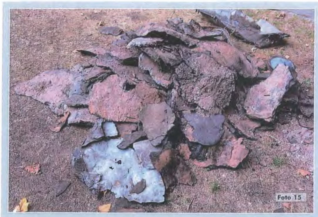
Rest alter Bitumenpappe
