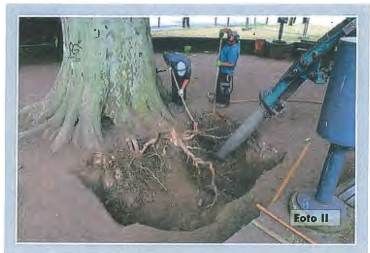
Mechanische und pneumatische Lockerung des Bodens
