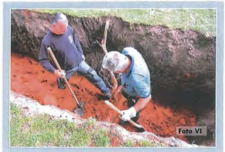
Das Füllmaterial wird lagenweise festgetreten.
