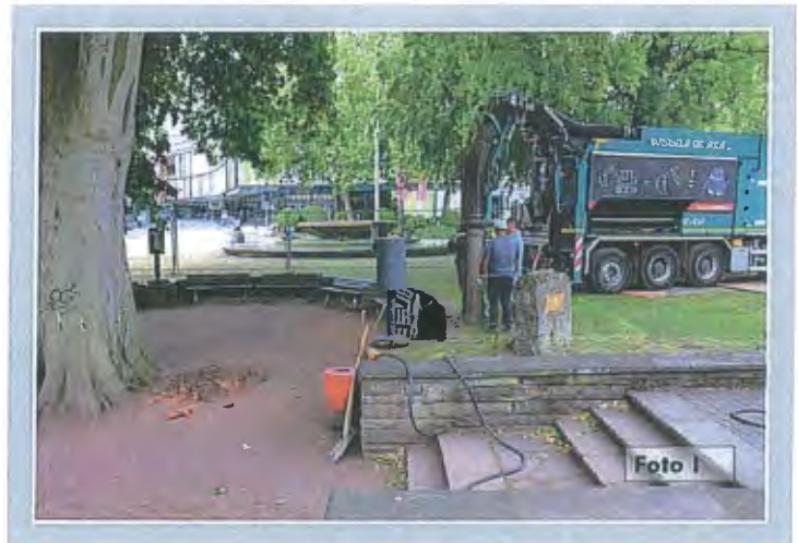
Montage des Saugrohres an Baggerüssel
