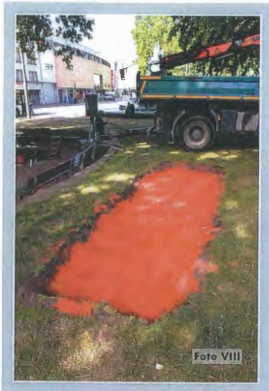
Die Sondiergräben innerhalb der Rasenfläche / der Pflanzbeete werden mit Oberboden überzogen.
