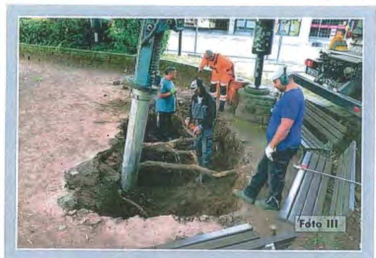
Das gelockerte Erdreich wird wurzelschonend abgesaugt.
