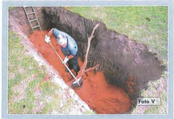
Händische Verteilung des Füllmaterials
