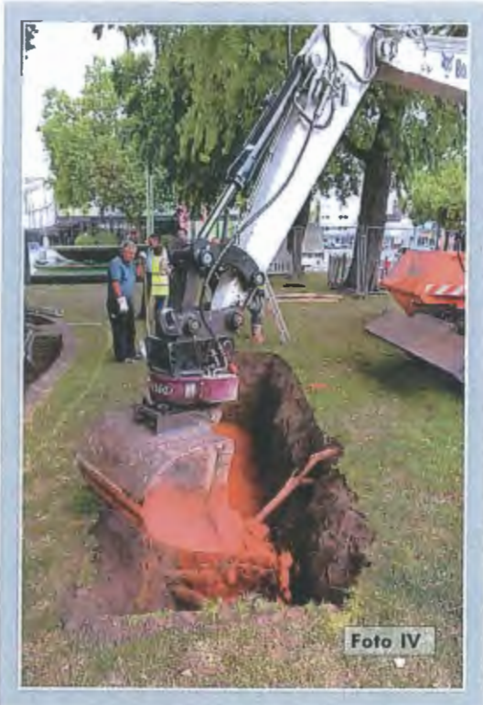
Verfüllung der Sondiergräben mit Sand
