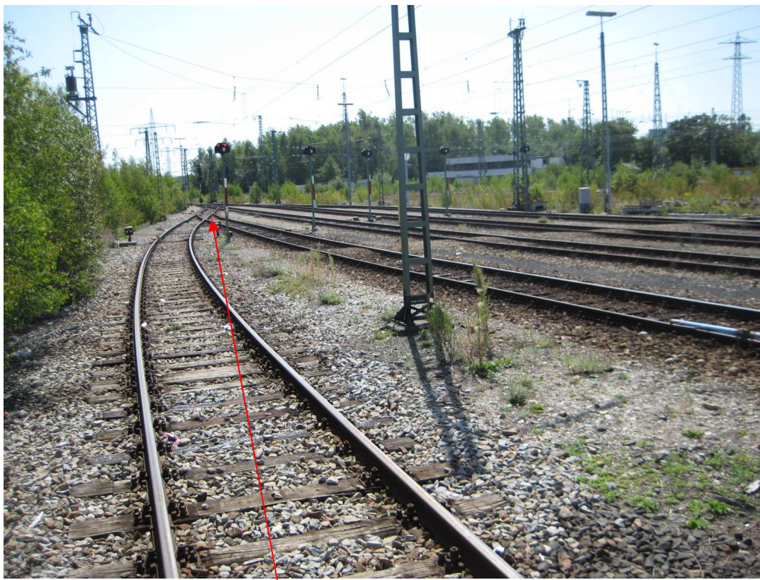
Zufahrtsgleis für Kopframpe, Weiche 26, Blickrichtung Süd
