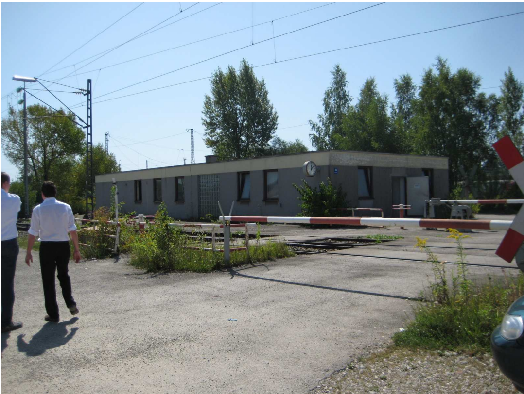
Bestehendes Gebäude (GFV), außerhalb der betrachteten Fläche, Blickrichtung Süd
