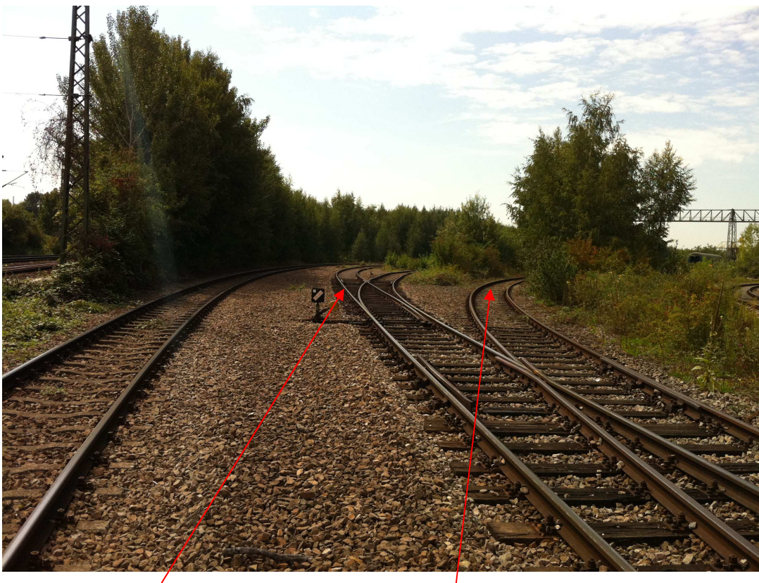
Zuführungsgleise Lagerflächen, Zuführungsgleis Maschinenpool Halle, Blickrichtung West
