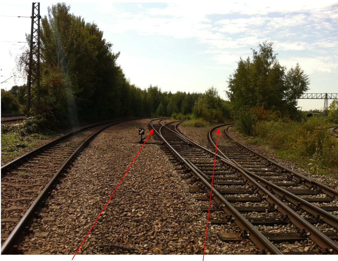
Zuführungsgleise Lagerflächen, Zuführungsgleis Maschinenpool Halle, Blickrichtung West
