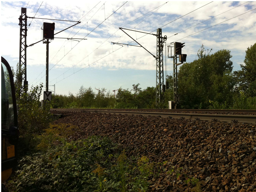
Strecke 4020, Blickrichtung West
