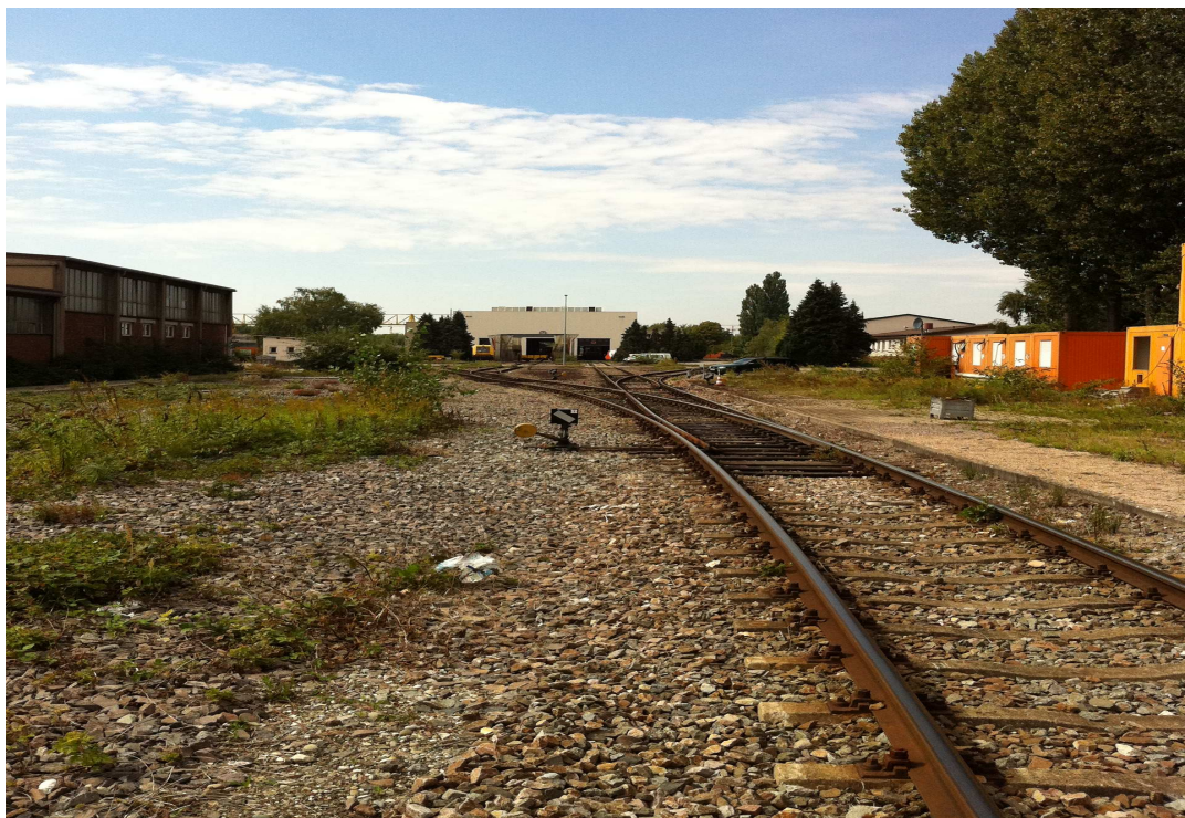
Maschinenpool Halle mit Zuführung, Blickrichtung West
