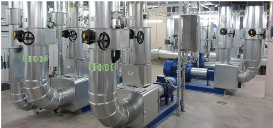
Die vom Supercomputer Hawk erzeugte Wärme wird zur Beheizung der Gebäude genutzt und die eingesetzte freie Kühlung benötigt deutlich weniger Energie als herkömmliche in Rechenzentren genutzte Klimaanlage. Foto: HLRS/Simon Sommer
