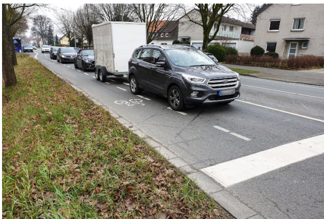
Abbildung 12: Fehlende vorgezogene Haltelinie am Knotenpunkt Elsener Straße/Bernhard-Hunstig-Straße (Foto: eigene Aufnahme)
