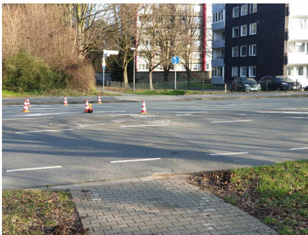
Abbildung 14: Markierte Querungshilfe für linksabbiegenden und querenden Radverkehr vor der LSA Riemekestraße/Heinixdorf-Straße. Die Querungshilfe ist vom Fahrbahnrand nicht gut zu erkennen und unauffällig (Foto: eigene Aufnahme)
