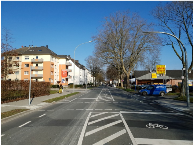
Abbildung 13: Markierte Querungshilfe an versetzter Einmündung der Giefersstraße und Jahnstraße in die Rathenausstraße. LSA ist vorbereitet (Foto: eigene Aufnahme)
