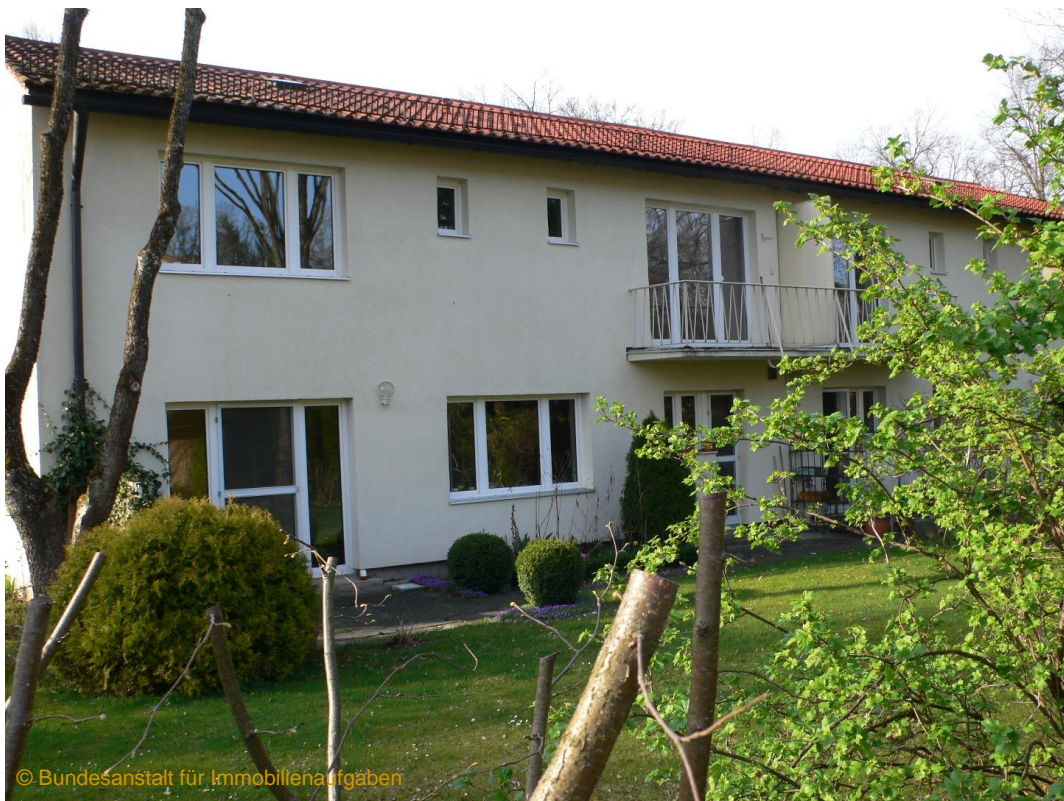
Rückansicht des Gebäudes
