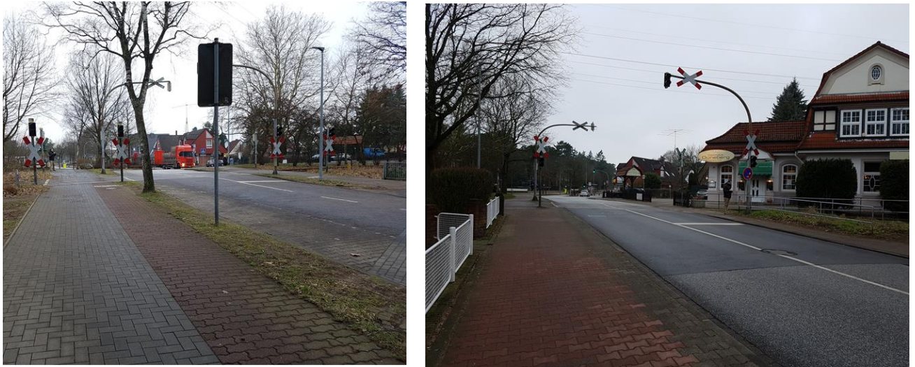
Abbildung 71: Geesthacht BÜ Neuer Krug und BÜ Düneberger Str. [Quelle: Eigene Aufnahmen]
