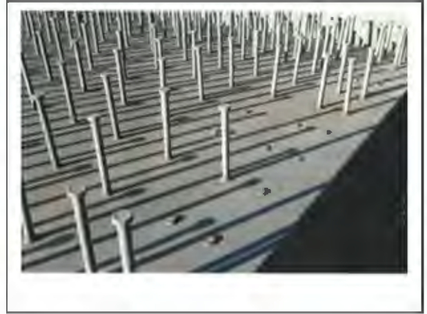
Bild 2: Kopfbolzendübel auf einem Hohlkasten
