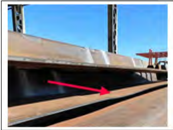
Bild 7: Beulverformung
