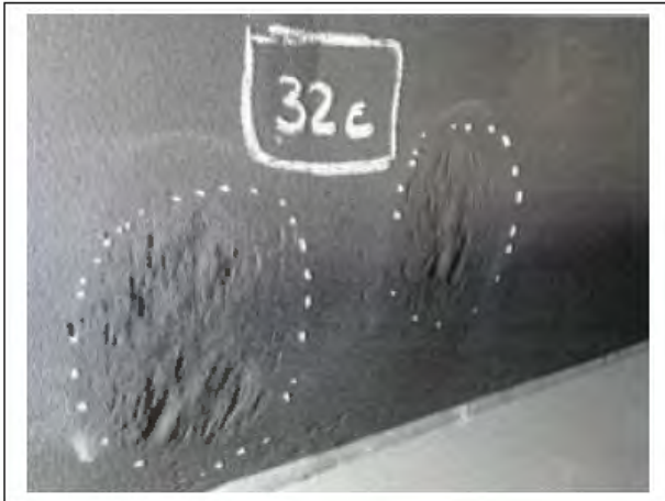
Bild 13: Schädigung am Schottblech
