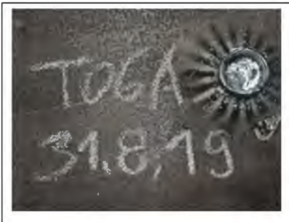
Bild 3: Mangelhafte Schweißverbindung eines Kopfbolzendübels (nach Entfernung des KBD)
