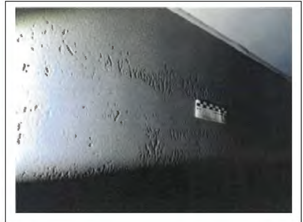
Bild 14: Ungenzen in der Oberfläche (Oberflächenunregelmäßigkeiten)
