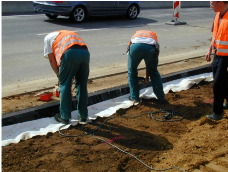
Abb. 47: Anschluss Kunststoffdichtungsbahn an Betonbauwerke mit Klemmschiene
