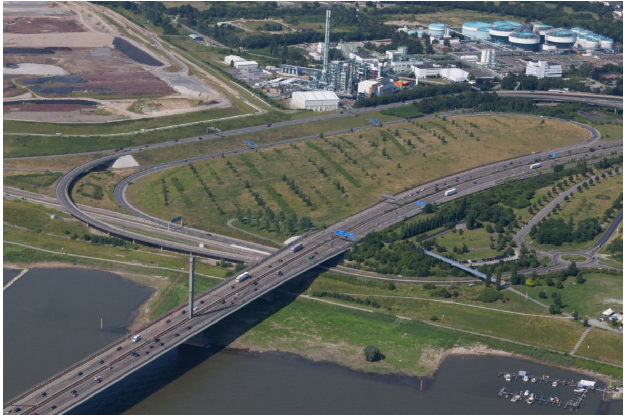
Abb. 12: Übersicht rechtsrheinisches Baufeld
