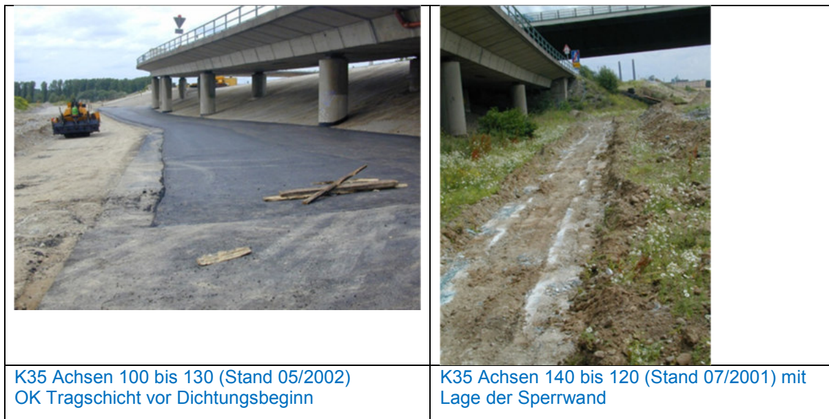
Abb. 32: Fotos zum Bau der Asphaltabdichtung im Bereich Brücke K35
