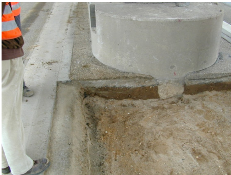
Abb. 44: Übergang vorh. Fahrbahn an Dichtungsasphalt (vor Dichtungsbeginn)
