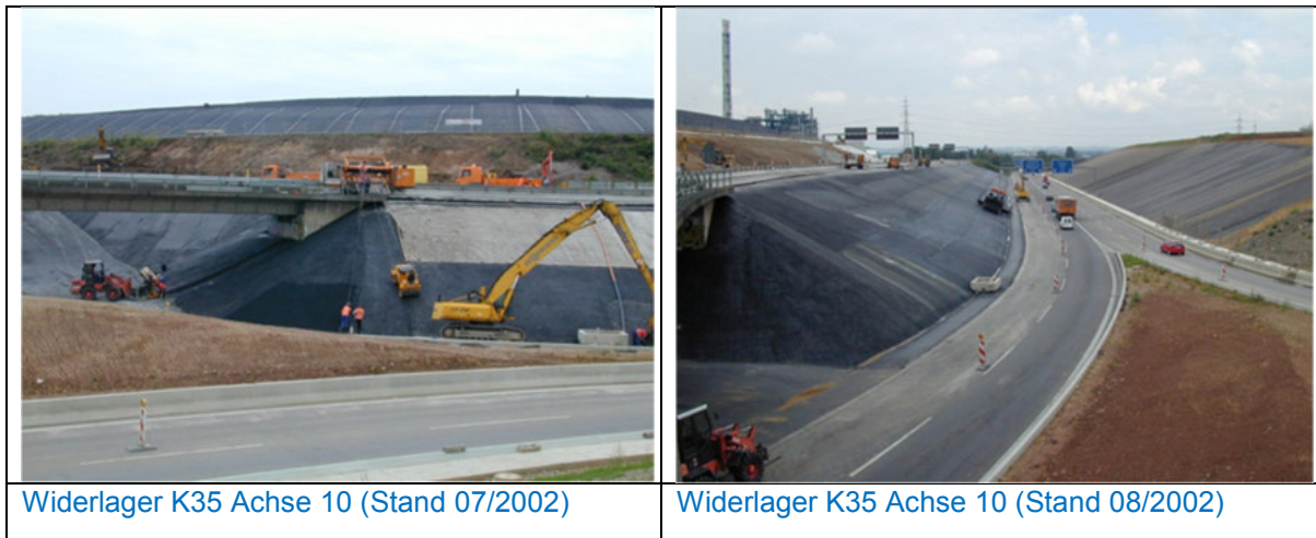
Abb. 19: Fotos zum Bau der Asphaltabdichtung im Bereich Brücke K35
