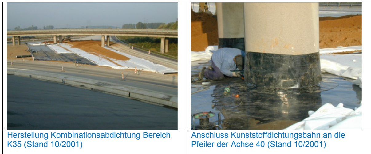
Abb. 24: Abdichtungsarbeiten an der K35 – Kombinationsabdichtung
