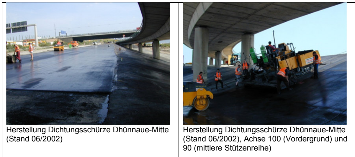
Abb. 31: Fotos zum Bau der Dichtungsschürze im Bereich Brücke K35
