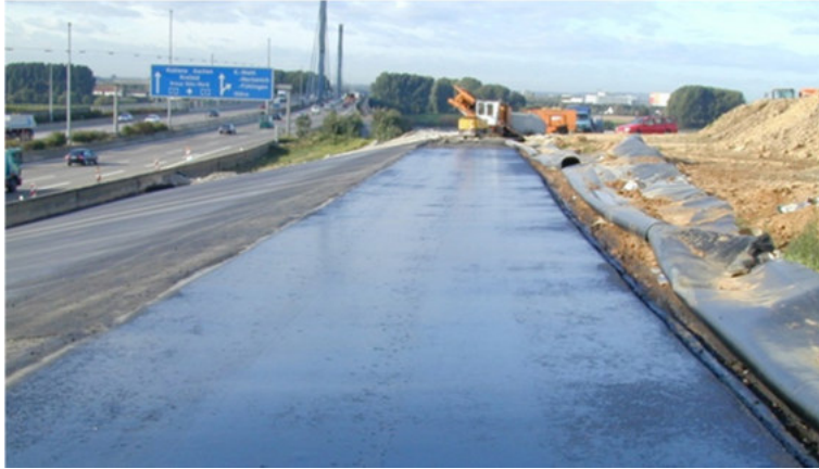
Abb. 49: Übergang Kunststoffdichtungsbahn an Asphaltabdichtung
