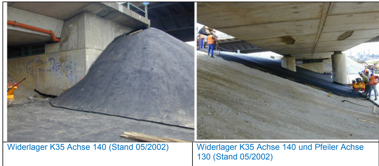
Abb. 35: Fotos zum Bau der Asphaltabdichtung im Bereich Brücke K35
