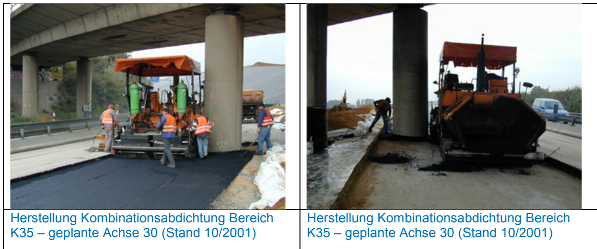
Abb. 26: Abdichtungsarbeiten an der K35 (Lage: Achse 30 geplant)
