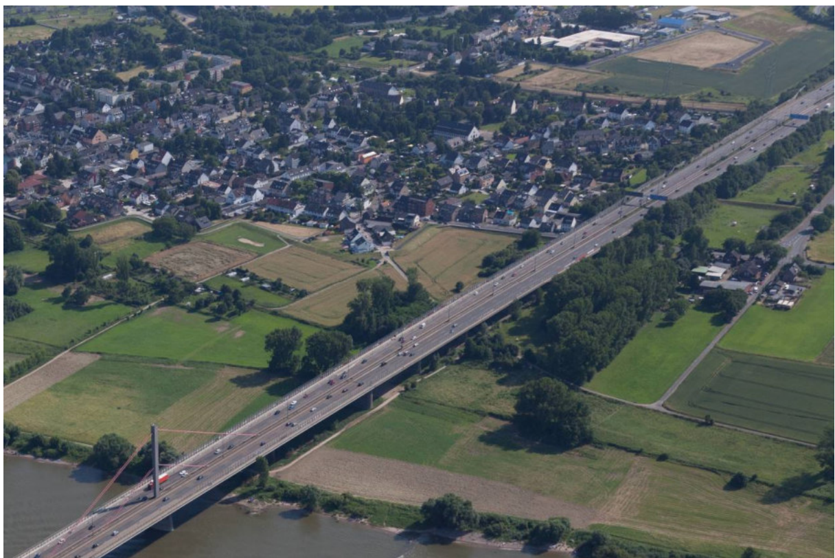
Abb. 13: Übersicht linksrheinisches Baufeld
