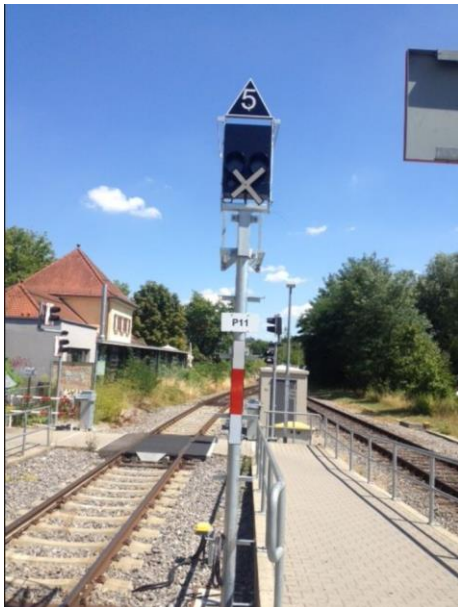
Abbildung 20: Barrierefreier, technisch gesicherter Zugang zu einem Mittelbahnsteig [Quelle: Zweckverband ÖPNV im Ammertal]
