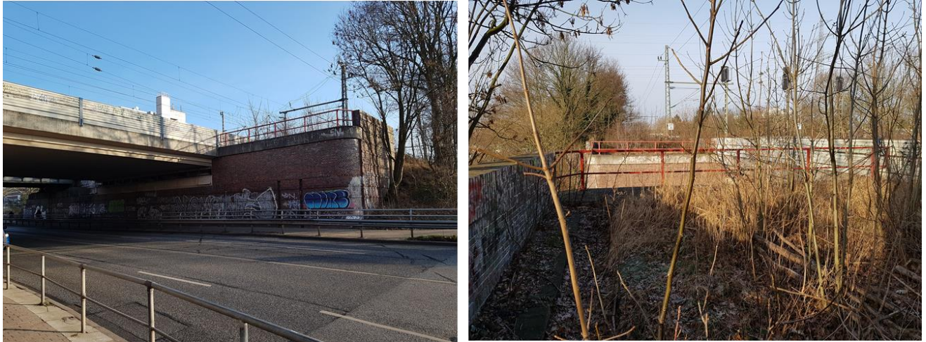
Abbildung 65: Hamburg-Nettelburg, EÜ Oberer Landweg [Quelle: Eigene Aufnahmen]
