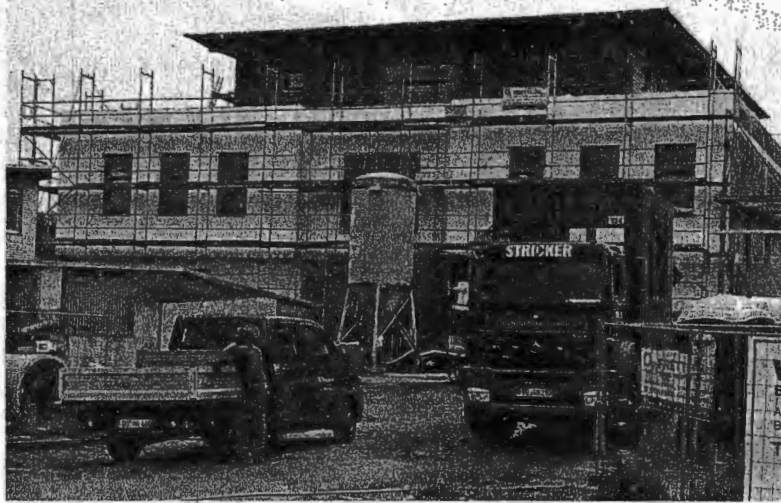
Im Rohbau fast fertiggestellt ist die neue Ausbildungswerkstatt in Genna. FOTO: H. RAUER
