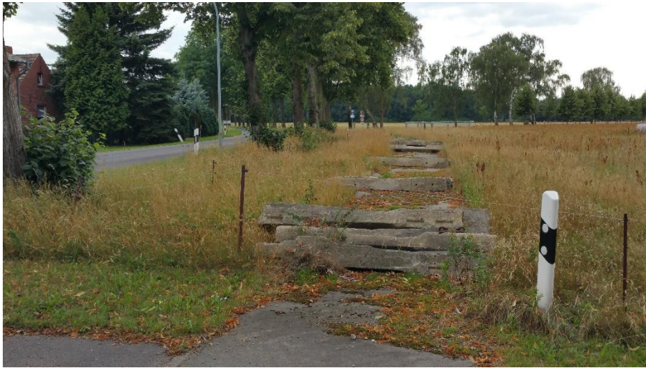
Blick auf den zugestellten Radweg, Foto IGP GbR Schulz, 04.08.2016
