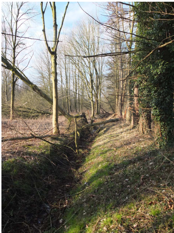
Foto 4: Entwässerungsgraben Grenze Plangebiet
