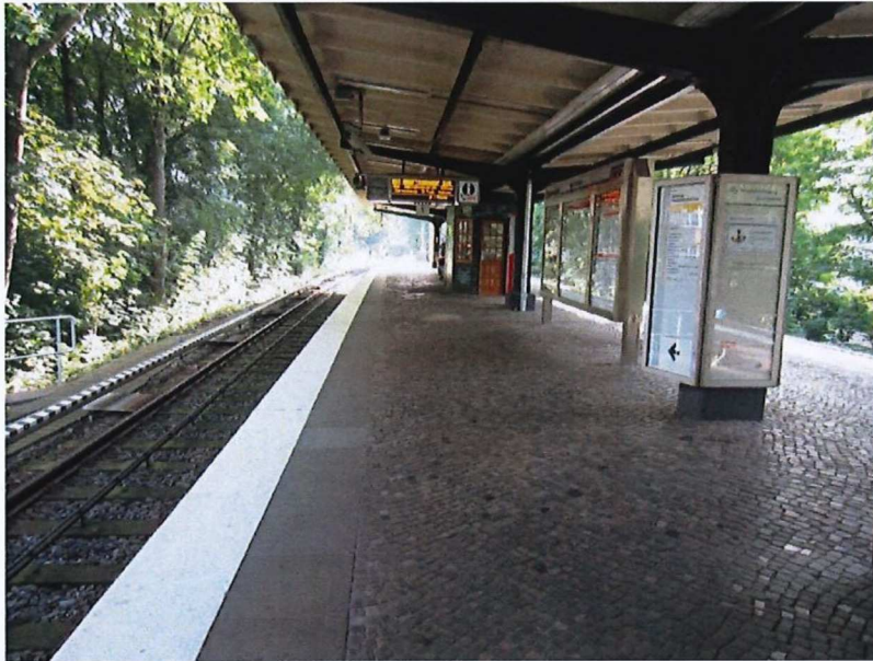
Foto Nr. 8 (Bahnsteig, Gleis 1).
