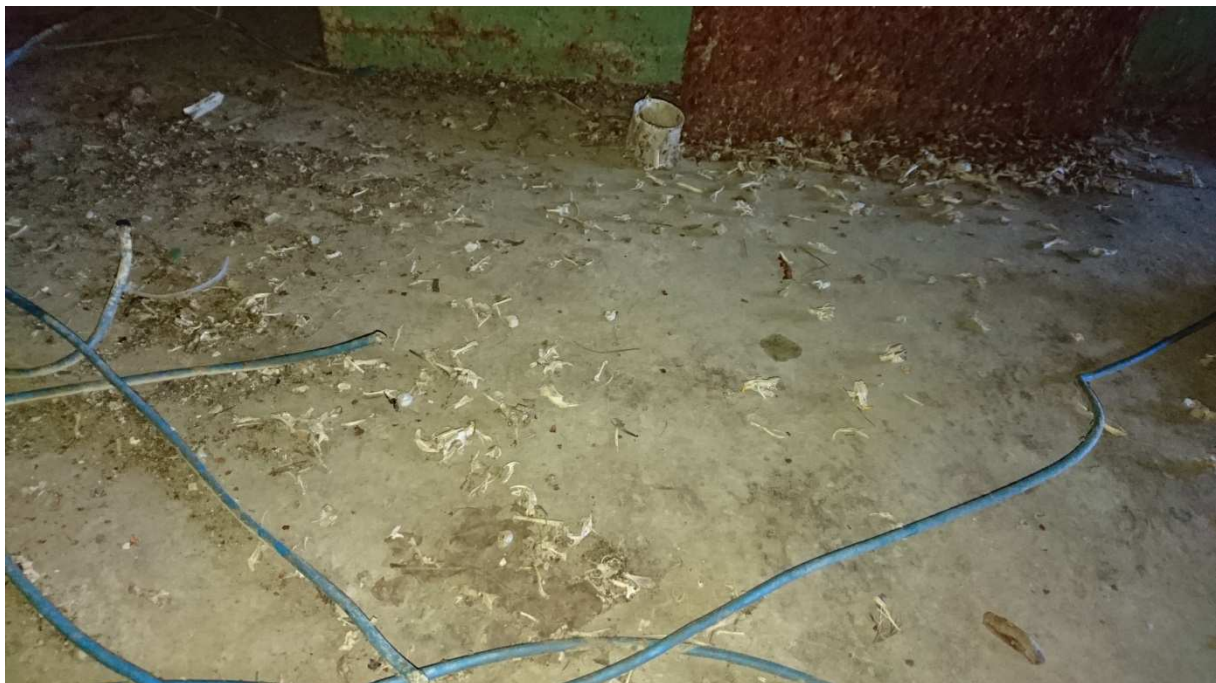
Abb. 13: Zerfallene Gewölbe des Waldkauzes
