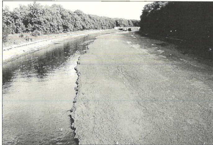
Abbildung 4: Massive Ablagerung von Sedimenten (Beispiel Flutbett der Elster, Foto: ECOSAX).
