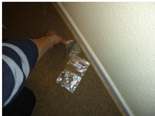
Abb.11: Ansicht Teppich Belag mit asbesthaltigen Kleber
