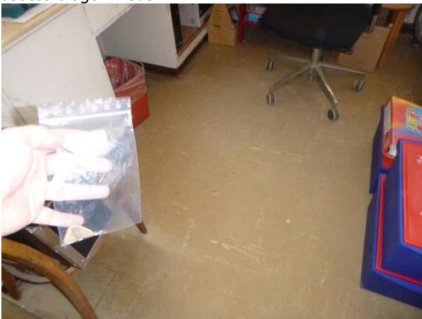
Abb.12: Ansicht asbesthaltige Floor-Flexplatten mit asbesthaltigem Kleber
