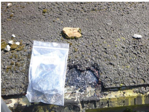
Abb.21: Ansicht Kernbohrung im Duschbereich
