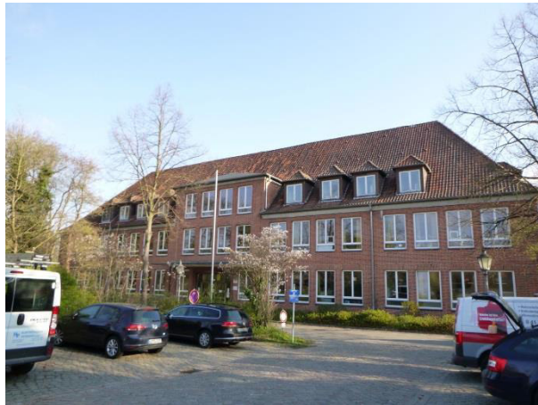
Abb. 1: Ansicht Hauptgebäude, Eingangsbereich
