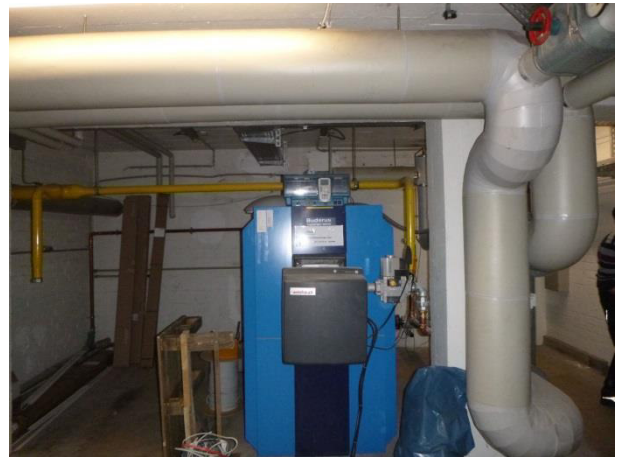
Abb. 16: Rohrisolierung Kunststoffhülle
