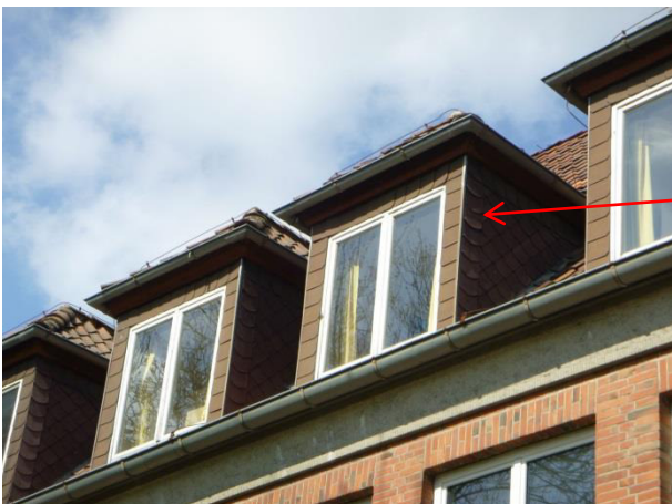
Abb.7: Ansicht AZ-Platte an Dachgaube
