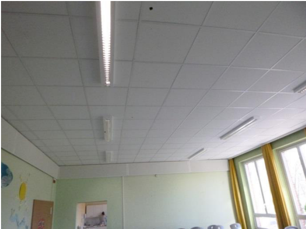
Abb. 18: Rasterdecke aus gepresster künstlicher Mineralwolle
