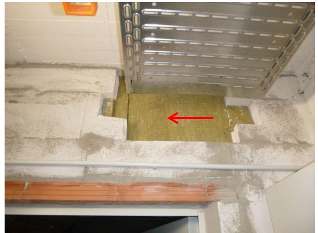
Abb.20: KMF als Trennlage
