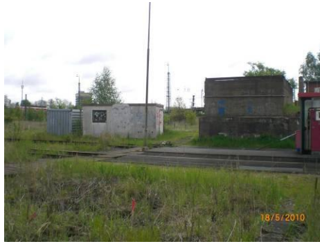
dto. östlich der Tankstelle
