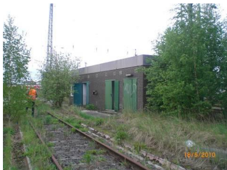
Pumpenhaus (westlich der ehemaligen Waschanlage gelegen).
