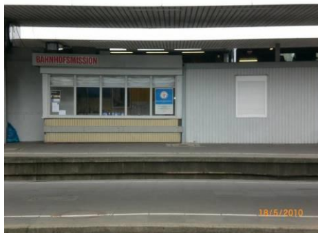
Diverse Bahnsteiggebäude vorhanden.
