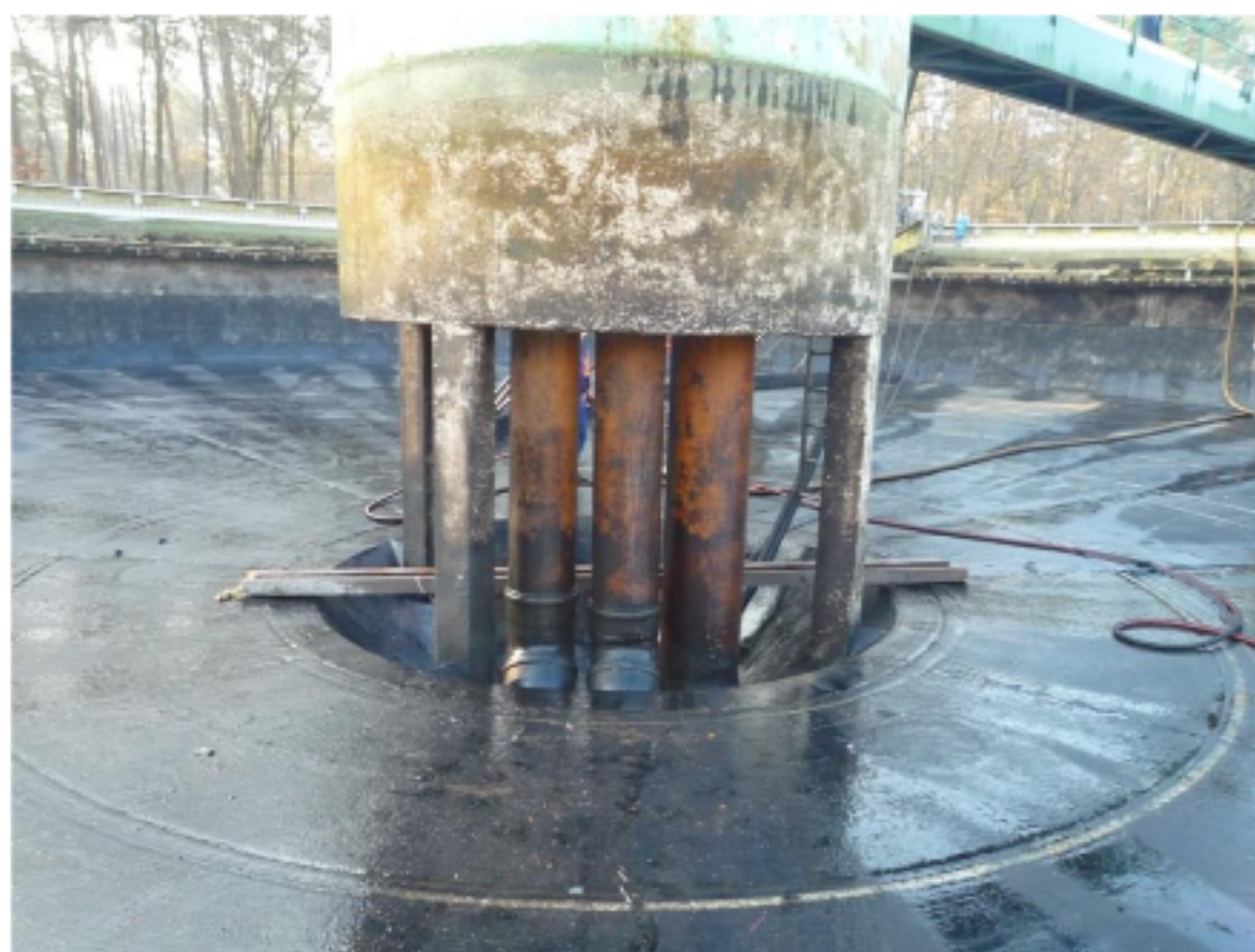
Abbildung 6: Mittelbauwerk Nachklärung im entleerten Zustand
