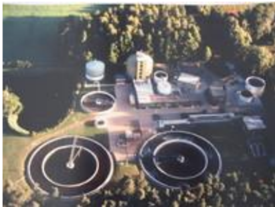
Abbildung 1: Übersichtsbild der Kläranlage Schloß Holte-Stukenbrock
