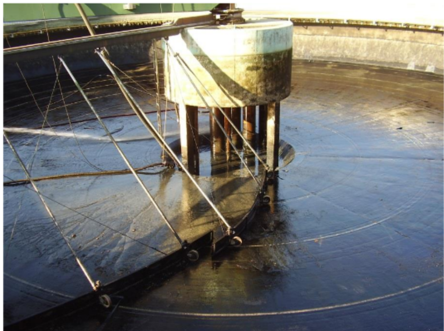
Abbildung 5: Nachklärung im entleerten Zustand
