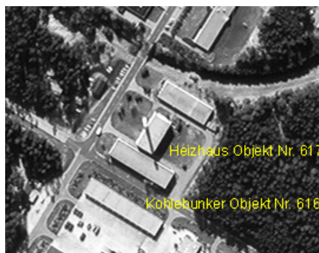
Abbildung 7-21: Heizhaus (Objekt Nr. 617, /3/) und Kohlebunker (Objekt Nr. 616, /3/), Luftbild von 1988
