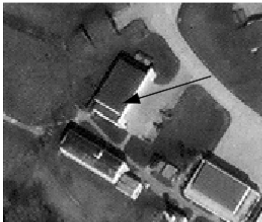
Abbildung 7-26: F104 Wartungshalle (Objekt Nr. 134, /3/), Luftbild von 1988
