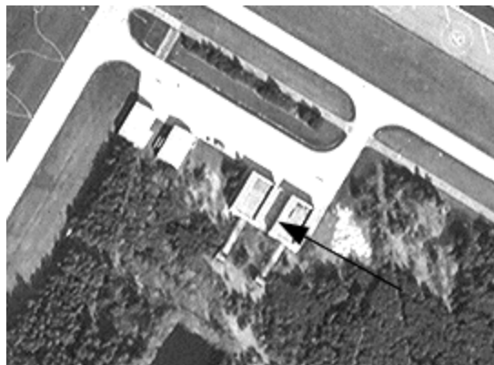
Abbildung 7-30: Triebwerksprüfstände (Objekt Nr. 246 und 247, /3/), Luftbild von 1988
