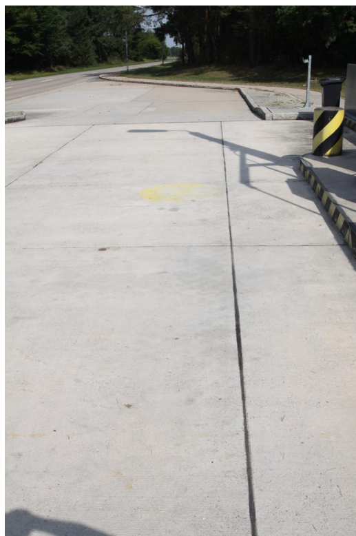
Abbildung 7-9: Intakte Fugendichtung bei Objekt 500
