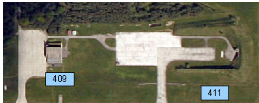
Abbildung 7-38: Justier- und Schießhalle (Objekt Nr. 409) und Justierschießstand mit Schießwall (Objekt Nr. 411), Luftbild 2005
