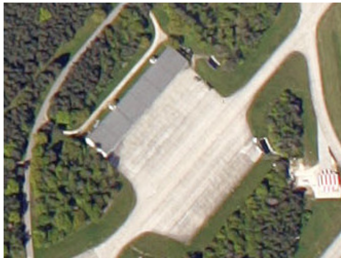
Abbildung 7-37: F 104 Abstellfläche (Objekt Nr. 301), Luftbild 2005
