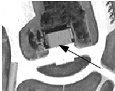
Abbildung 7-27: F104 Wartungshalle (Objekt Nr. 307, /3/), Luftbild von 1988
