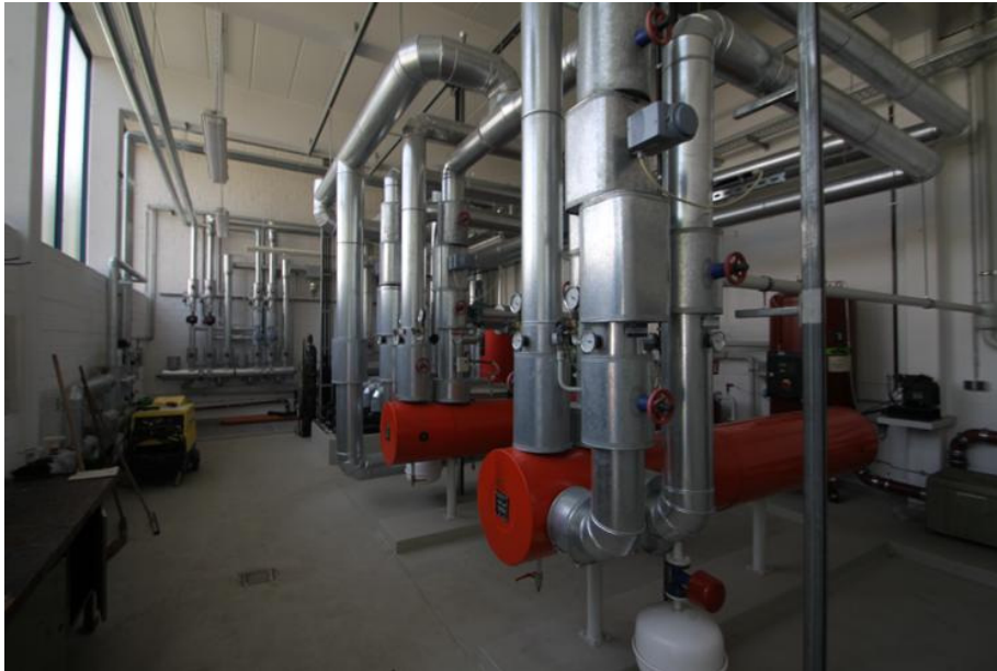
Abbildung 7-20: Heizhaus Objekt Nr. 142 (KVF 34), heutiger Zustand
