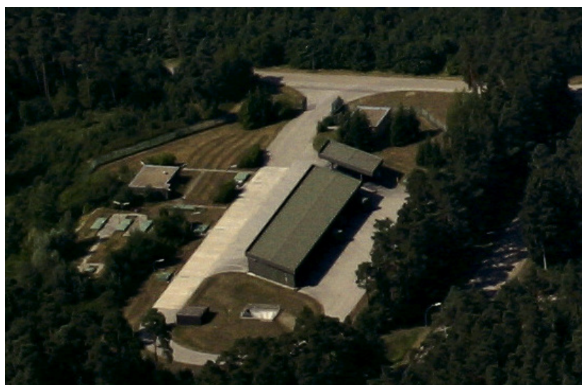
Abbildung 7-6: Tankstelle (Objekt Nr. 429), Luftbild von 2003
