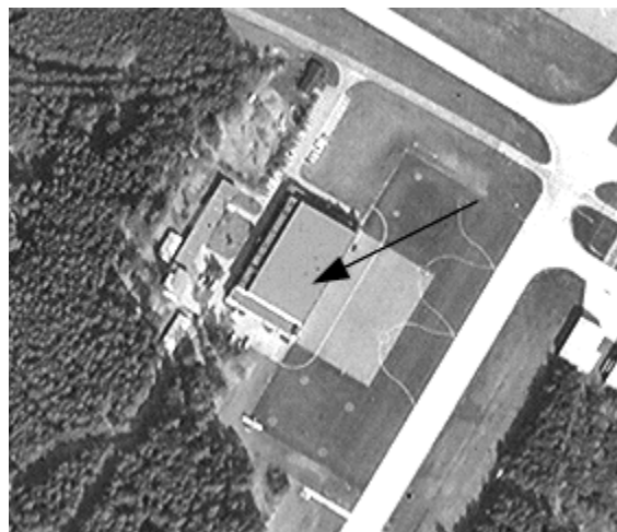
Abbildung 7-23: Werfthalle 2 (Objekt Nr. 236, /3/), Luftbild von 1988
