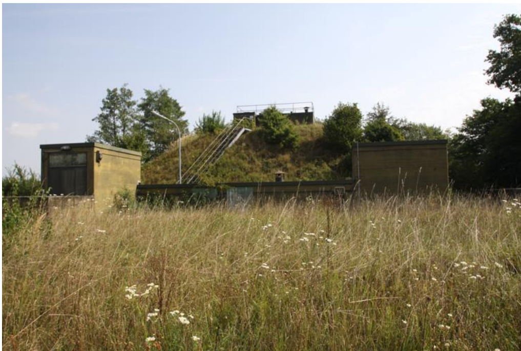
Abbildung 7-1: POL-Lager Objekt-Nr. 242 mit Pumpenhaus
