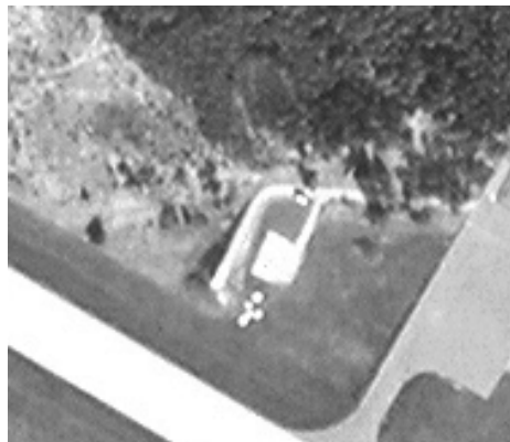
Abbildung 7-42: Aufschüttung „Feldherrnhügel“, Luftbild 1988
