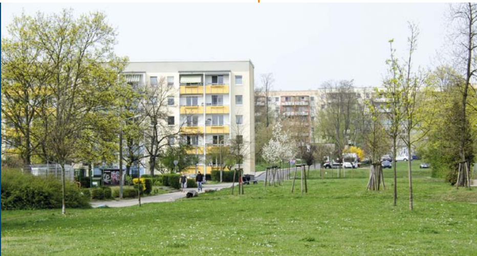
Sanierter Plattenbau, Stadtteil Süd in Frankfurt
