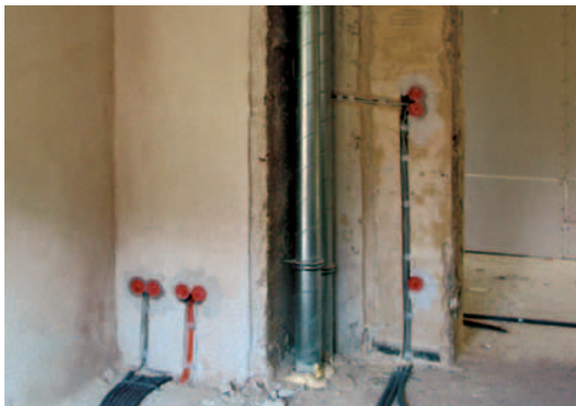
Lüftungskanal neben einem Kaminzug (vor Verkleidung)
