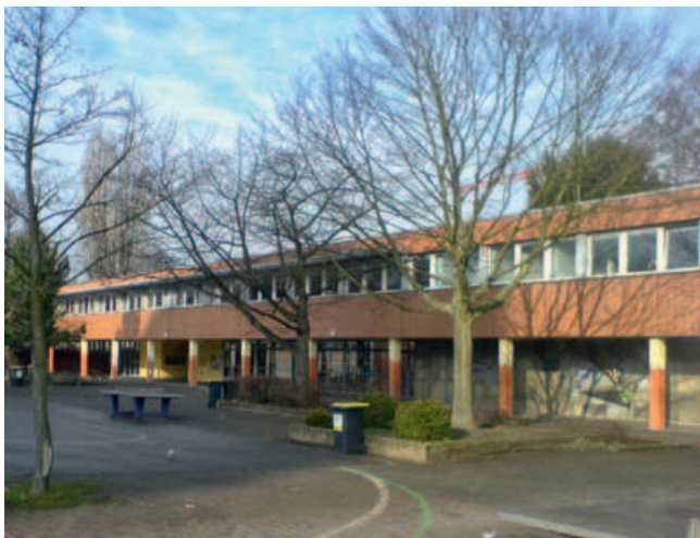
Gebäude vor der Modernisierung
