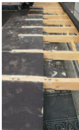
Wärmedämmung des Flachdachs
