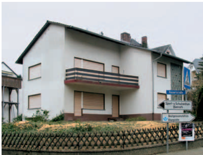
Gebäude vor der Modernisierung
