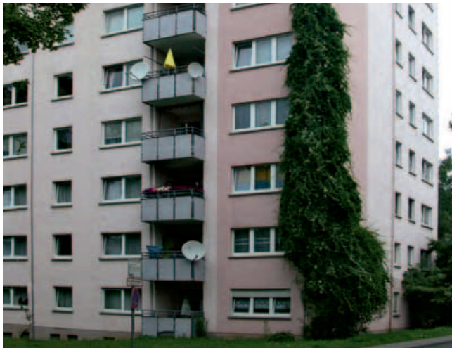
Gebäude vor der Modernisierung
