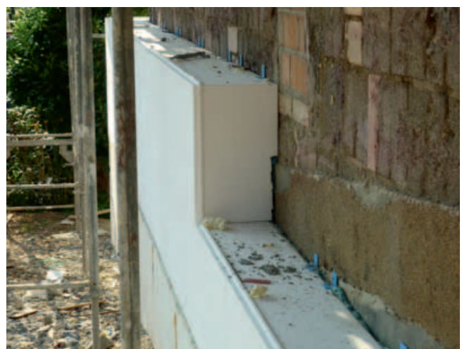
Außenwanddämmung mit einem WDVS
