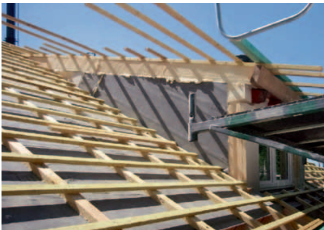
Dämmung der Dachgaube
