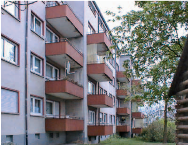
Gebäude vor der Modernisierung
