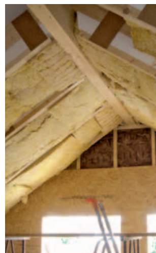
Zwischensparrendämmung des Schrägdachs
