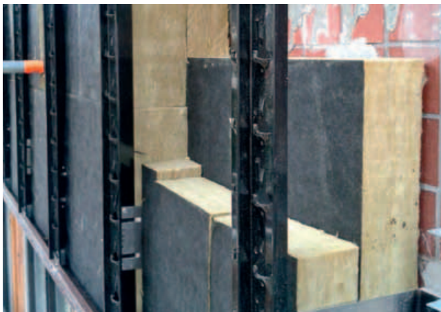
Unterkonstruktion der Vorhangfassade mit Wärmedämmung
