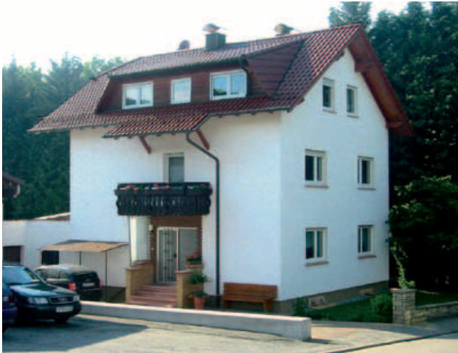
Gebäude vor der Modernisierung
