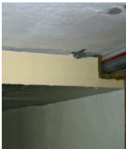
Kellerdeckendämmung mit Einbeziehung von Rohrleitungen
