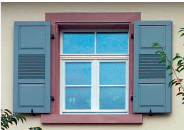
Fenster nach der Modernisierung
