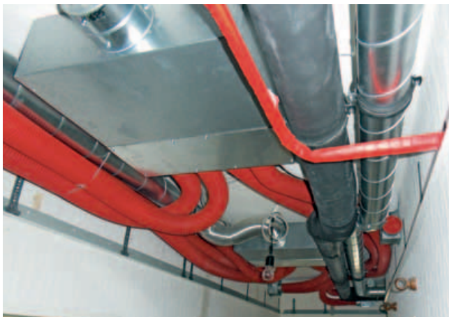
Lüftungsanlage in der abgehängten Decke (vor Verkleidung)
