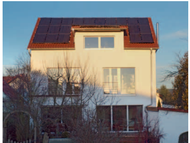
Gebäude nach der Modernisierung
