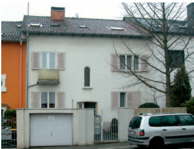
Reihenhaus in Frankfurt vor der Modernisierung
