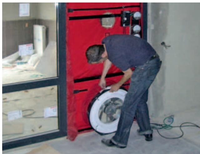
Vorbereitung einer Blower-Door-Messung
