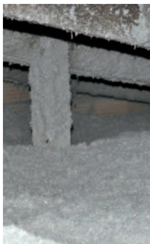
und nach der Einblas-Dämmung
