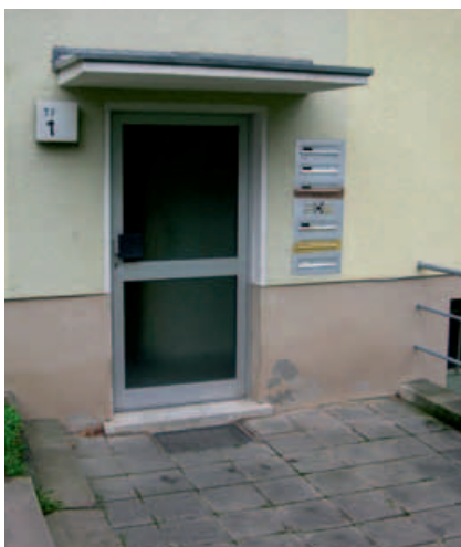
Vorher: auskragendes Vordach
