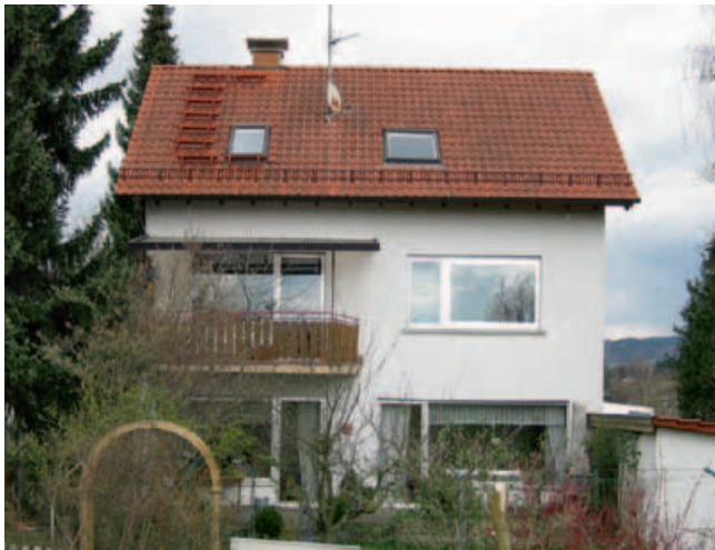
Gebäude vor der Modernisierung
