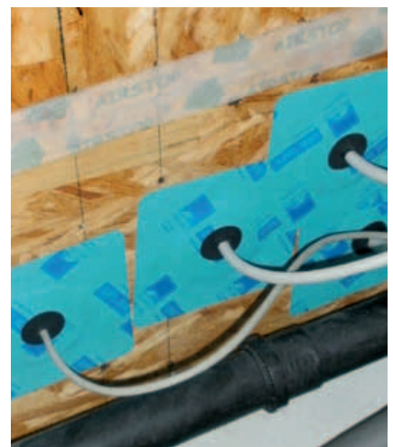
Luftdichte Durchführung von Elektrokabeln
