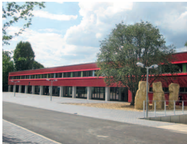
Gebäude nach der Modernisierung
