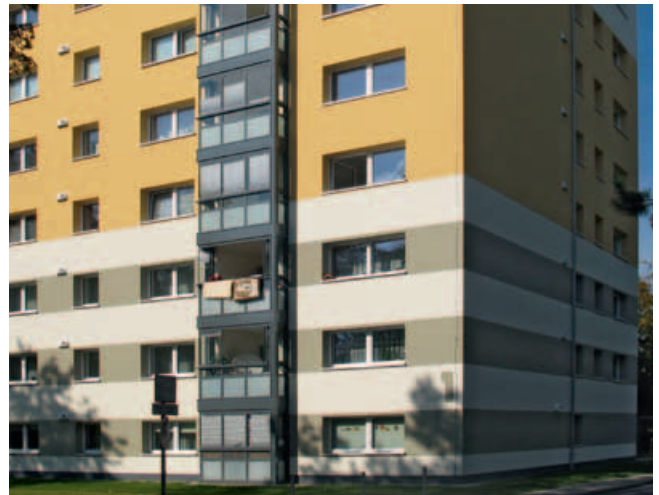
Gebäude nach der Modernisierung
