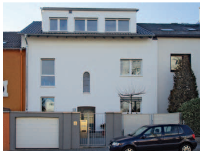
Reihenhaus nach der Modernisierung u. a. mit 30 cm WDVS
