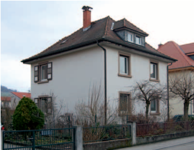
Gebäude vor der Modernisierung
