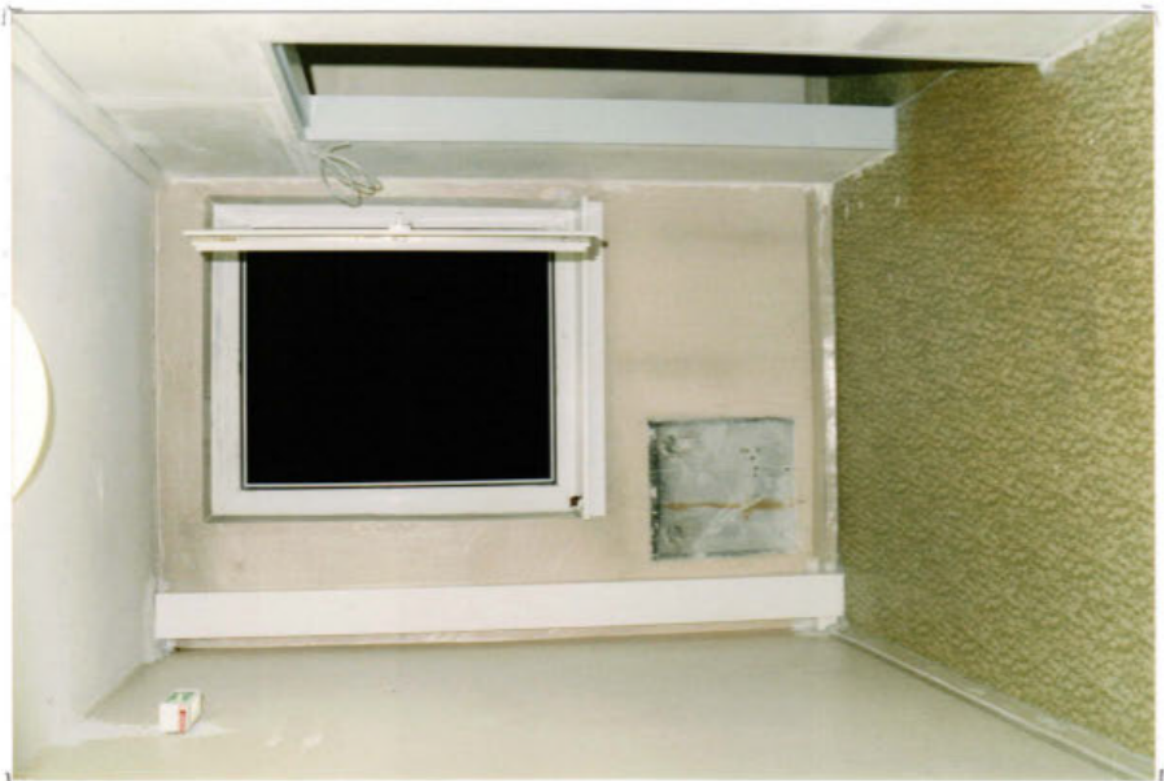
Bild 3 zeigt das geöffnete äußerste Flurfenster des 6. OG; lotrecht unter diesem Fenster liegt die Puppe (siehe nachfolgende Fotoaufnahmen!).
